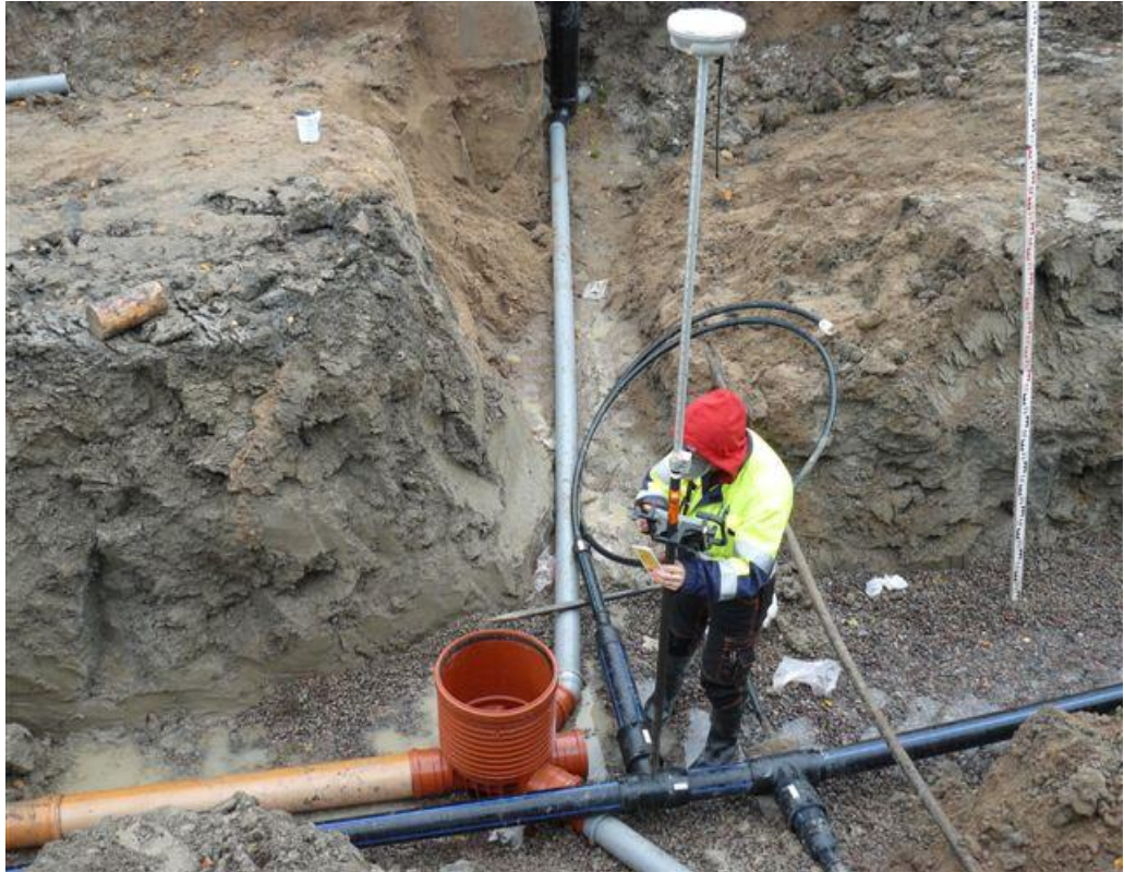
Kuva 4. Kaivojen ja tonttiliittymien GPS mittaus.
