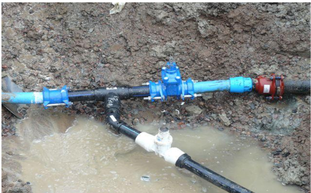
Kuva 3. Uuden vesijohdon liitos.
