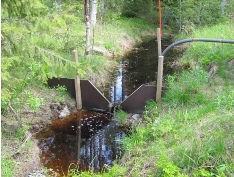
Kuva 8 V-mittapato maastossa Kirmanjärvellä. Padon takana näkyy musta muoviputki jonka sisään on asennettu paineanturi. Valokuva Jussi Haapamaa 2012.
