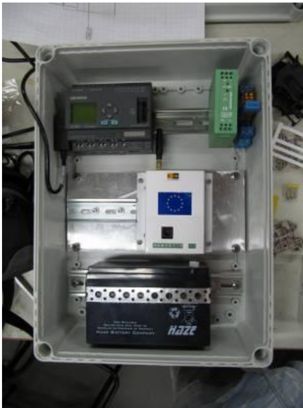
Kuva 10 Järjestelmän rakentamisen alkuvaihe. Valokuva Jussi Haapamaa 2012.
