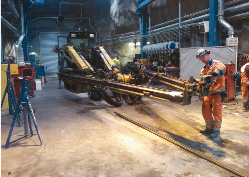
Kuva 3. Atlas Copcon poran huolto menossa maanalaisessa huoltotilassa. (kuva Kimmo Keltamäki 2013)
