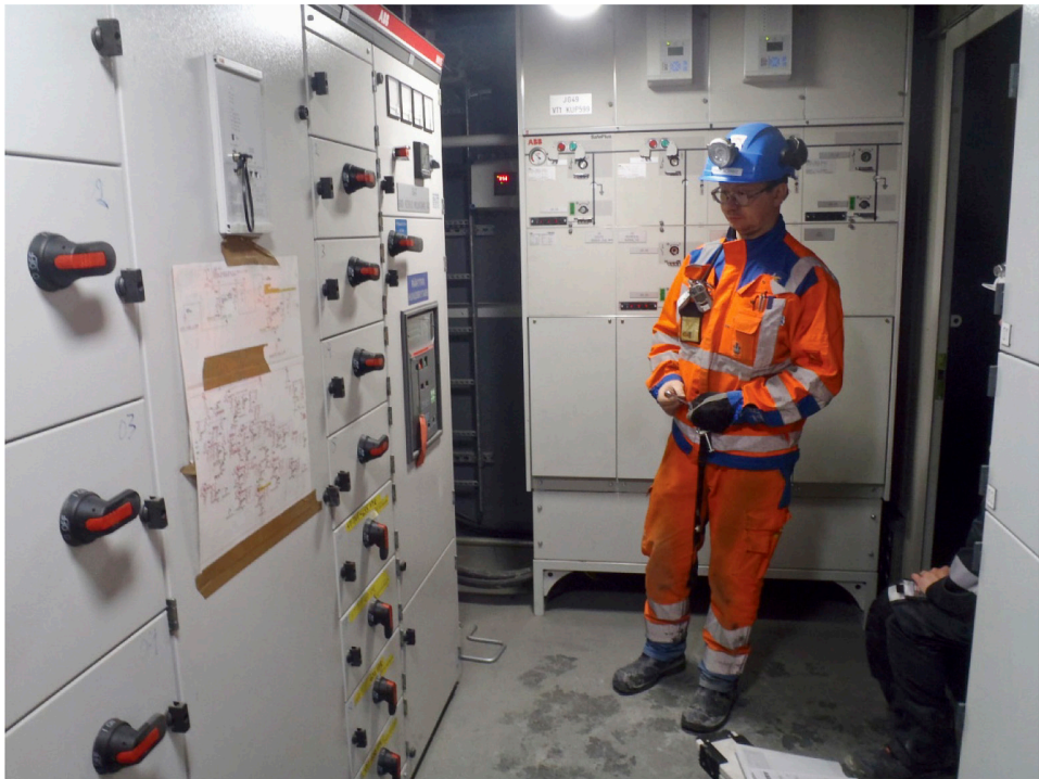
Kuva 13. Prosessikeskus 690 V, taustalla edellisen kuvan kojeisto. [kuva Jaakko Etto 2013]
