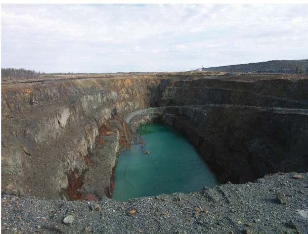
Kuva 2. Rouravaaran avolouhos, käyttötarkoituksena on nyt puhtaan veden välivarasto. (kuva Kimmo Keltamäki 2013)
