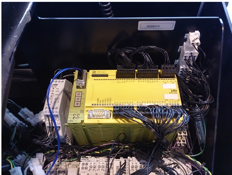
Kuva 29. Pilz-turvarele ja CAN-liityntä moduuli
