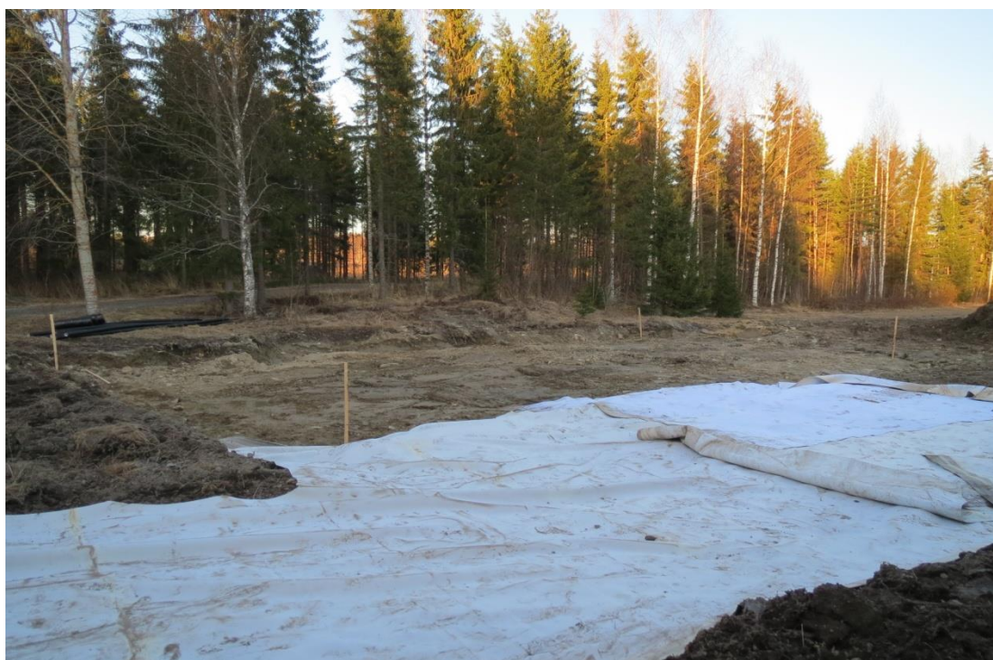
KUVA 2. Rakennuksen pohjatyöt (Laakkonen 2013)
