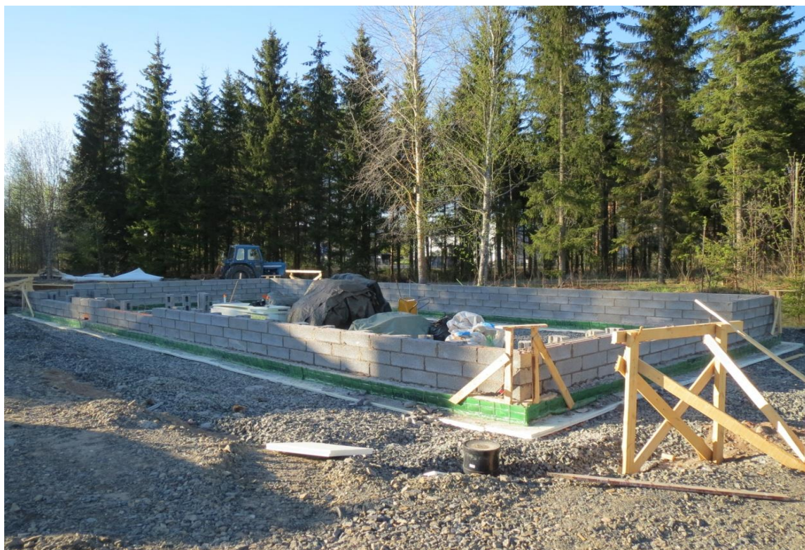
KUVA 7. Sokkelin valmistuminen (Laakkonen 2013)
