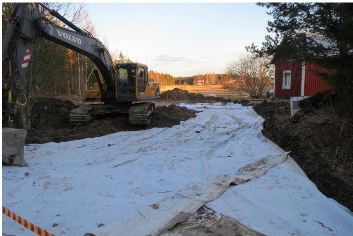
KUVA 3. Tienpohjan teko (Laakkonen 2013)
