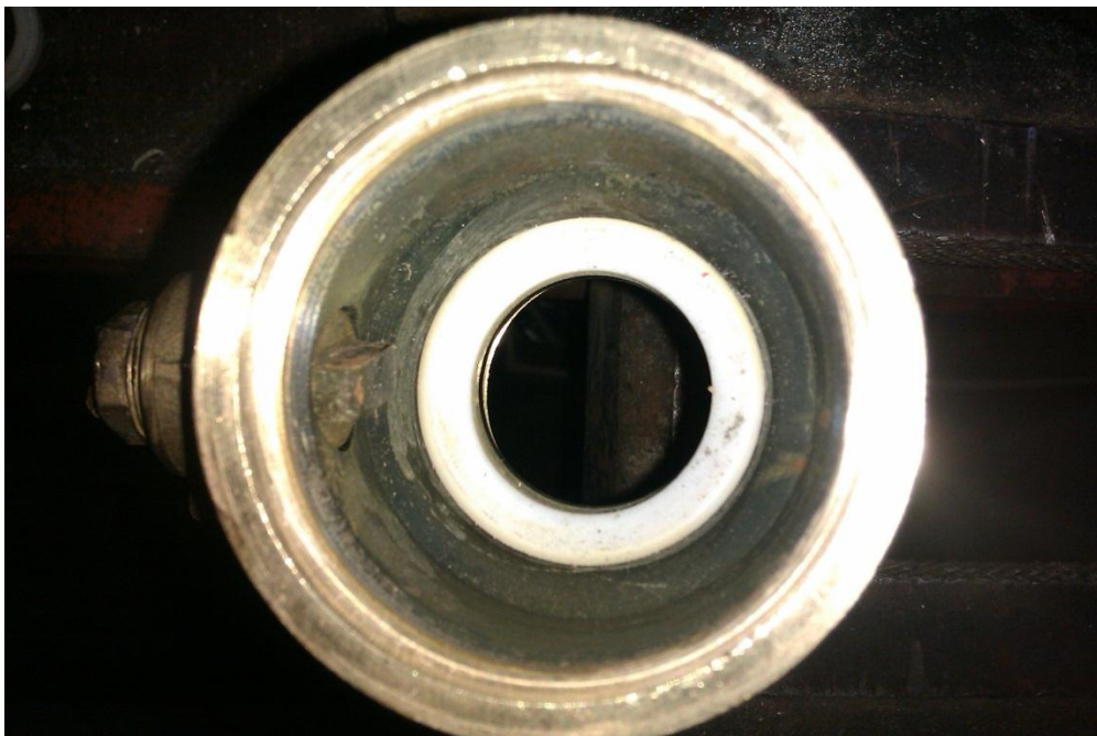
Kuva 25. Venttiilin pesä. Pesän pohjalla näkyy toinen tiivistävä teflonrenkas, joka on myös vaihdettavissa. Pesän vasemmassa reunassa näkyy karan uloke, johon pallon ura sopii.
