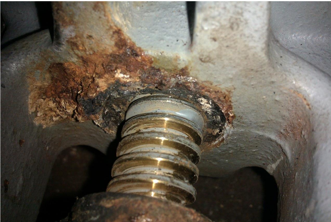
Kuva 21. Venttiilin karan poksitiiviste kannessa
