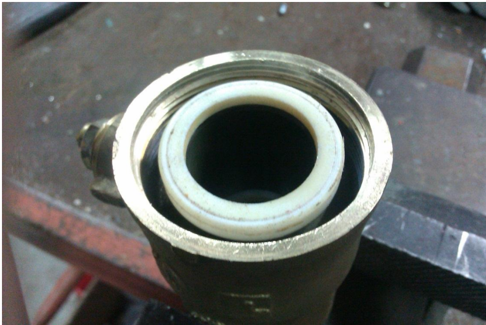
Kuva 23. Venttiilin pääty on irrotettu ja päällä näkyy tiivistävä teflonrenkas
