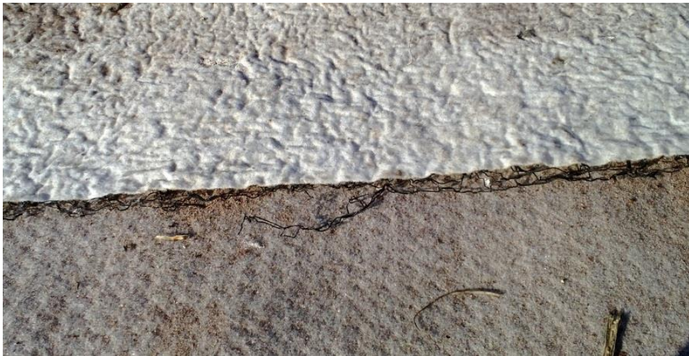
Kuva 11. Salaojamattoa bentoniittimatton päällä (kuivatus- ja tiivistekerros)
