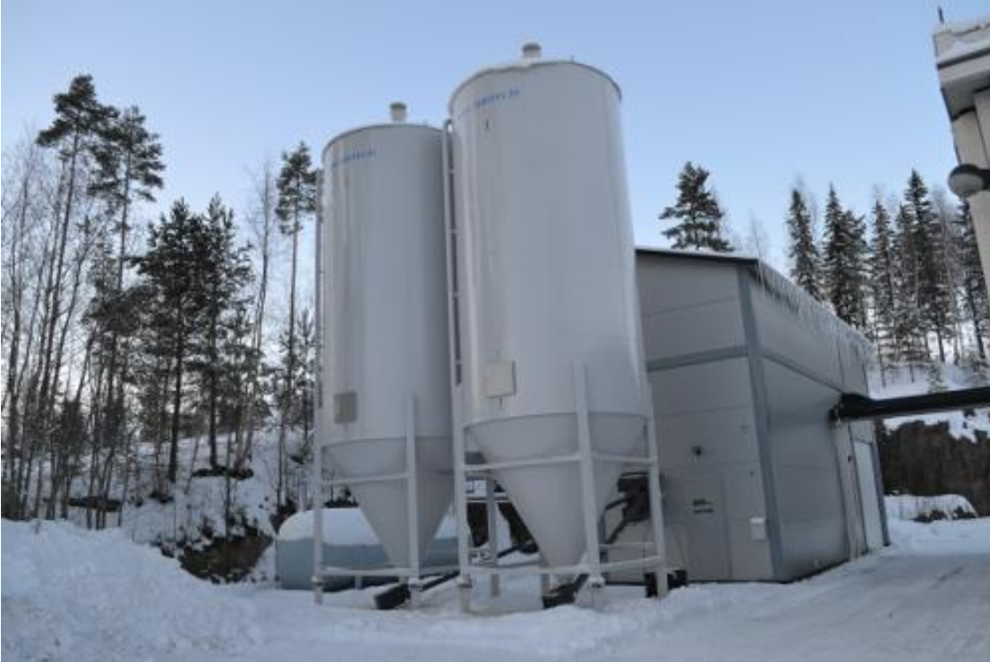
KUVA 6. Tyypillinen muutaman MW lähilämpölaitos
