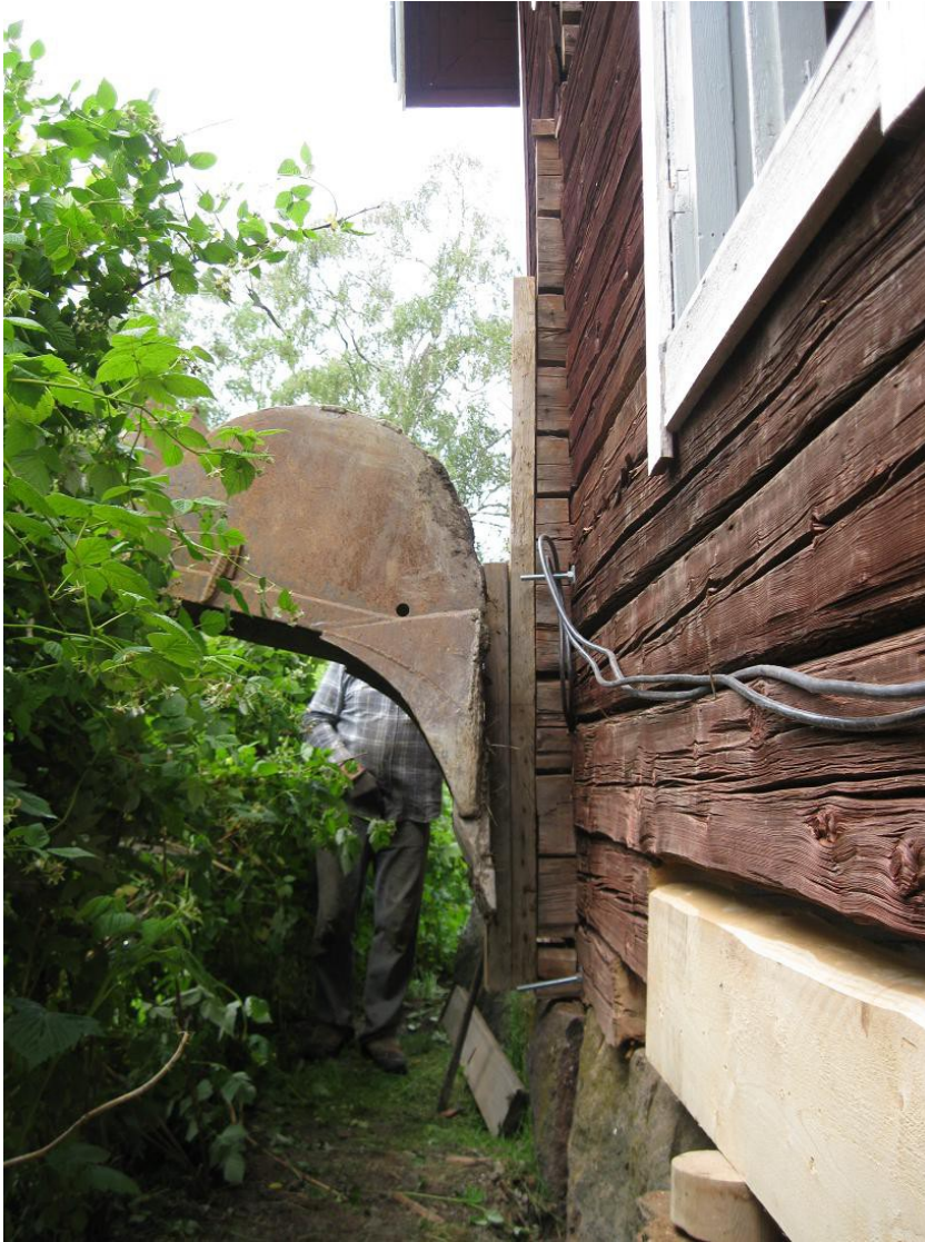
Kuvio 7: Seinärakenteen työntö kaivinkoneella
