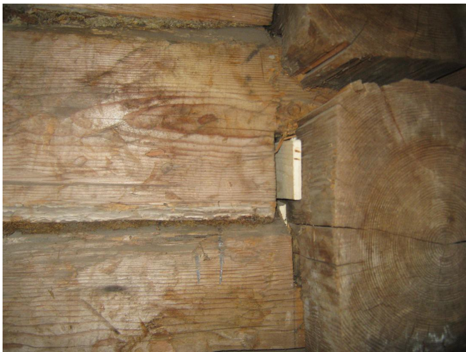
Kuvio 8: Oikaistu nurkka, vanha sijainti ja vetotunkin oikaisu merkittynä lyijykynällä
