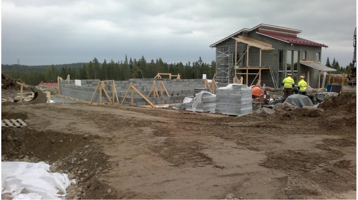
Kuva 6. Jyväskylässä rakennetaan asiakkaille työurakkana.
