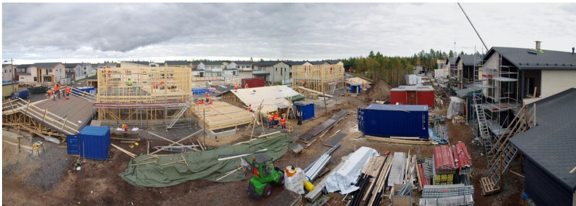
Kuva 8. Oulussa pyritään saamaan seitsemän tonttia kerrallaan. Huomaa, että katot tehdään valmiiksi maassa.
