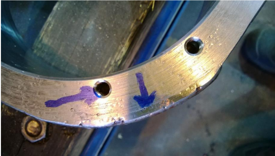
KUVA 18. Vesitilan koeponnistuksessa havaitut vuotokohdat
