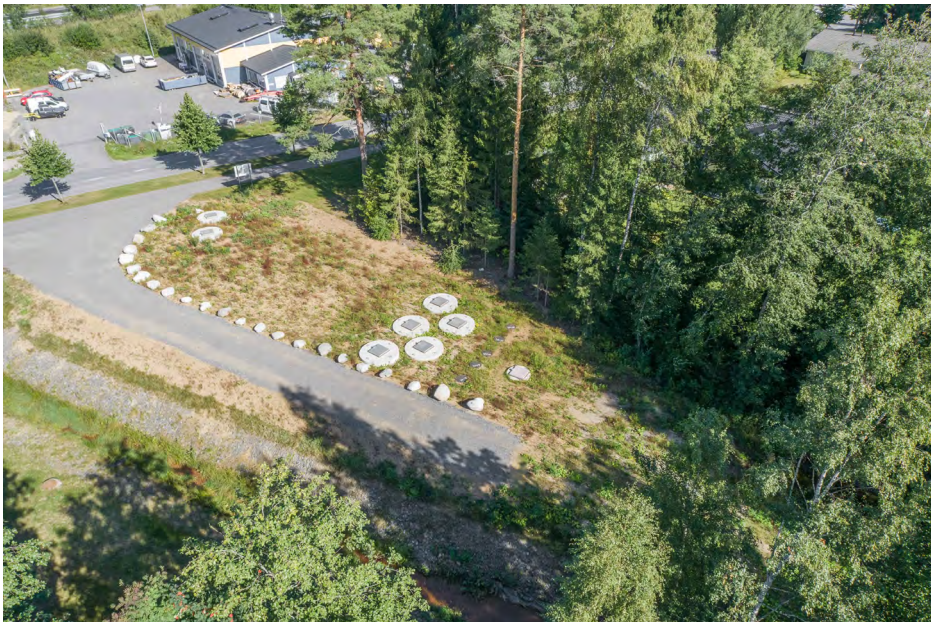
KUVA 2. Pitkäljärven hulevesien käsittelyjärjestelmä. Kuvassa näkyvät viisi rinnakaista kaivoa sisältävät itse suodatinmateriaalit (kuva Juha Vihavainen).
