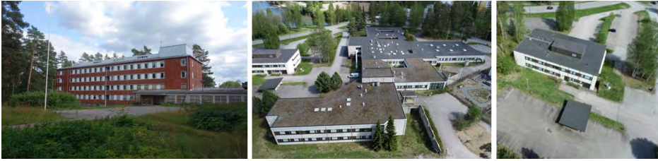
KUVA 1. Kuvassa vasemmalla Tuukkalan vanha sairaala ja keskellä ja oikealla Pankalammen terveyskeskuksen rakennukset (kuvat Esa Hannus).
