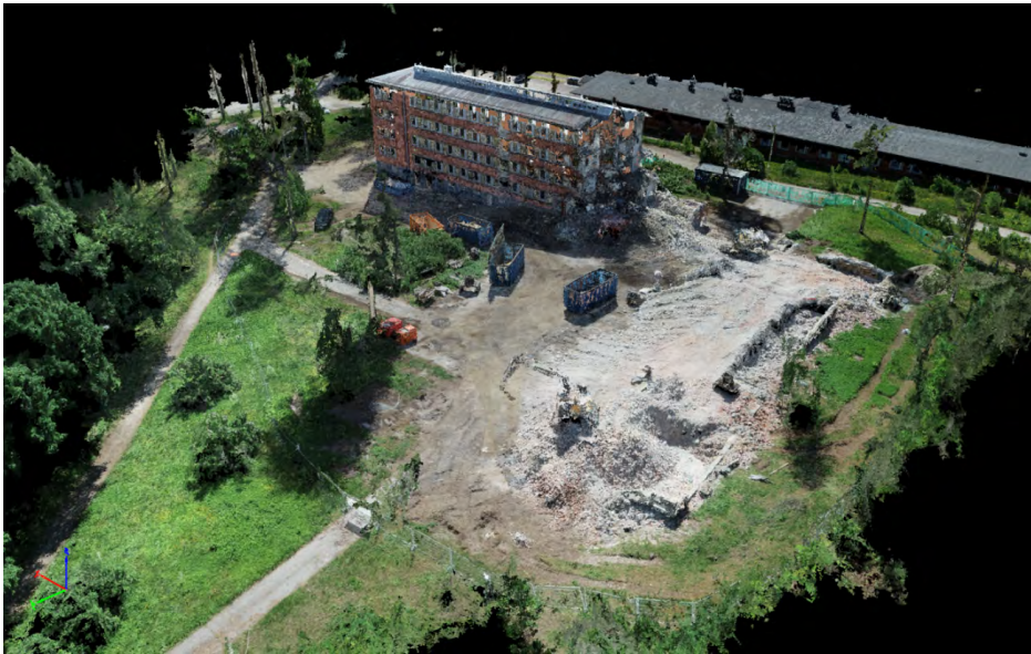
KUVA 4. 3D-pistepilvimalli Tuukkalan purkutyömaasta (kuva Juha Vihavainen).
