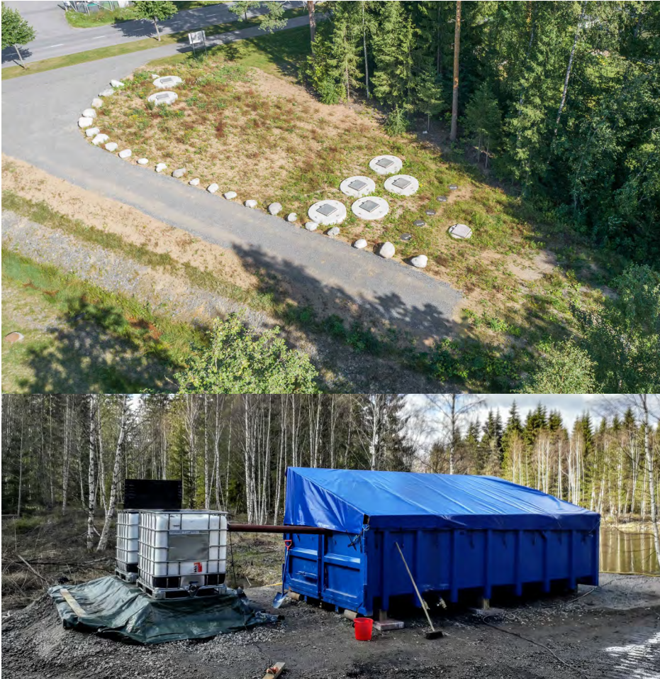
KUVA 1. Huky-hankkeessa monitoroitiin ja kehitettiin Pitkäjärven hulevesien käsittelyjärjestelmää (ylempi) sekä Ristiinan vanhan kaatopaikan suotovesien biosuodatuslaitteistoa (alempi) (kuvat Juha Vihavainen & Aki Mykkänen).
