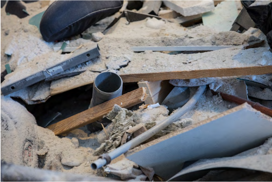
KUVA 1. RAPURC-hankkeessa edistetään rakentamisessa ja purkamisessa muodostuvan materiaalin hyötykäyttöä (kuva Manu Eloaho).
