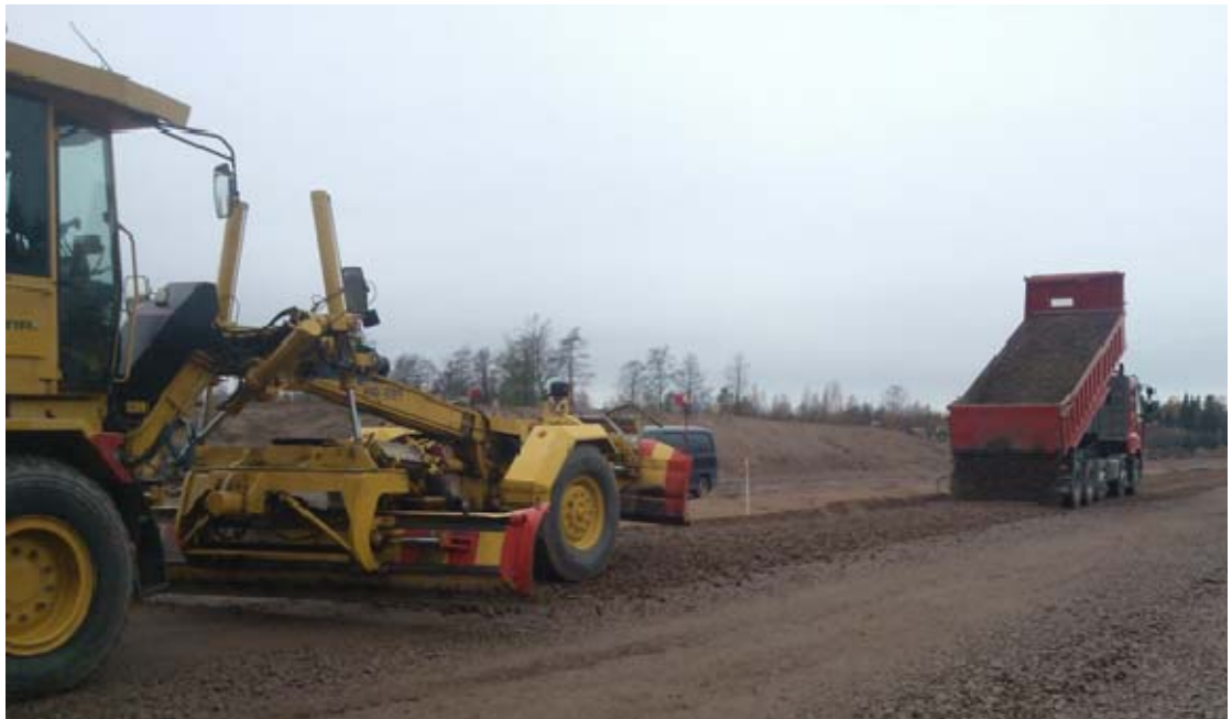
Kuva 23. Murskeen ajo ja levitystyö käynnissä
