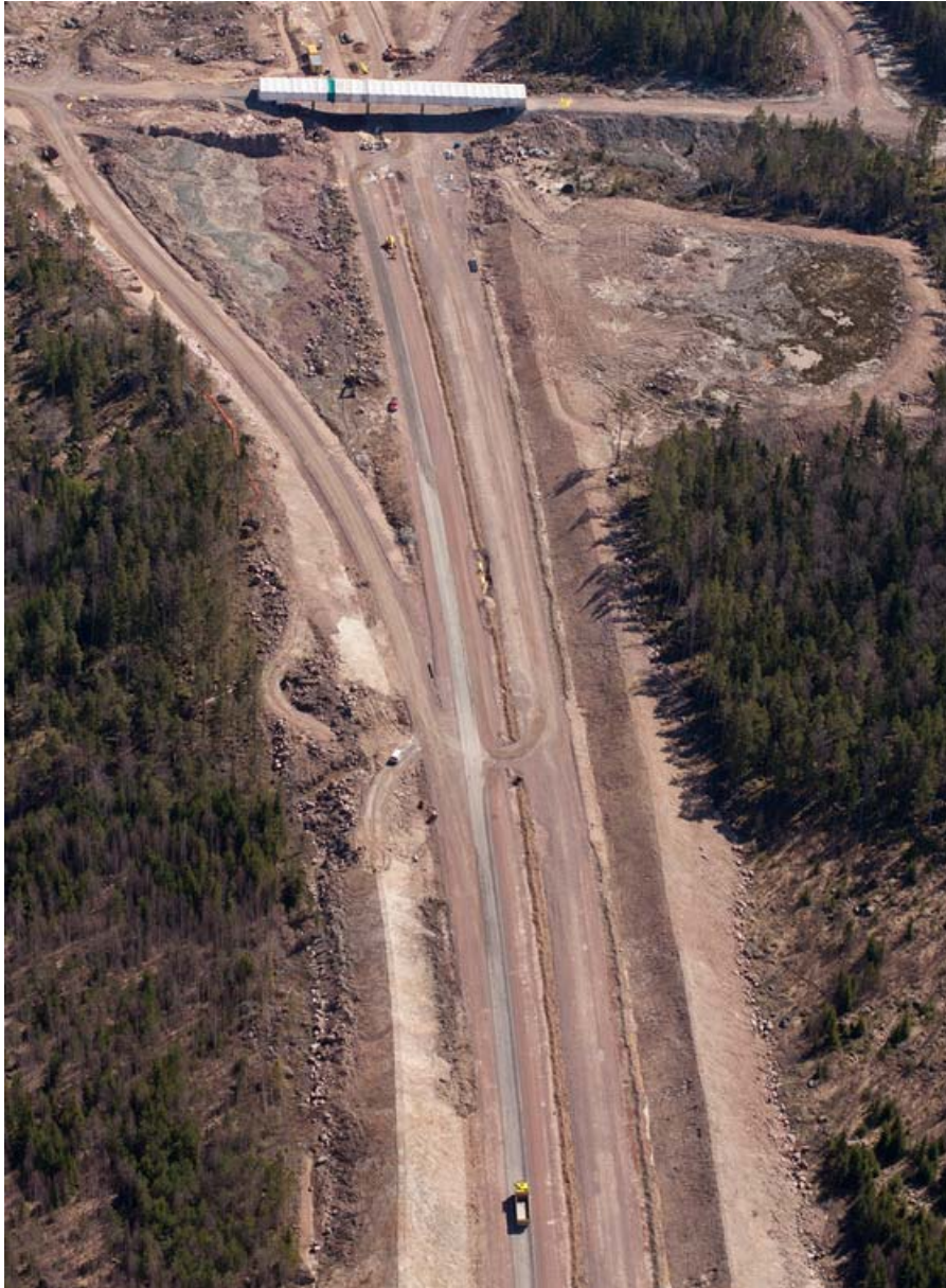
Kuva 24. Valmis kantava kerros rakennuskohteessa (1.)
