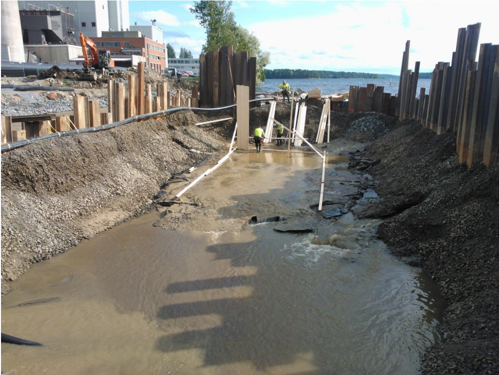
Kuva 11. Altaan muottityöt käynnissä (Männikkö 2012–08–27)
