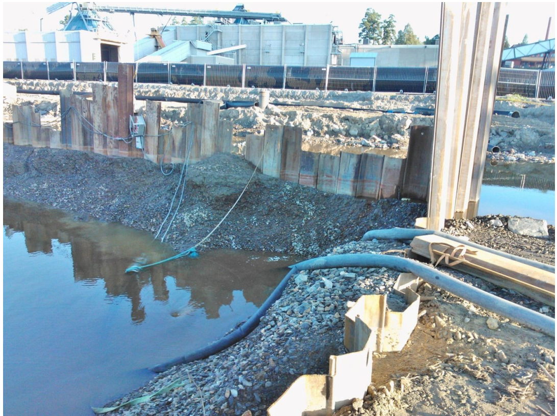
Kuva 8. Pumppaukset aloitettu. (Männikkö 2012-08-20)
