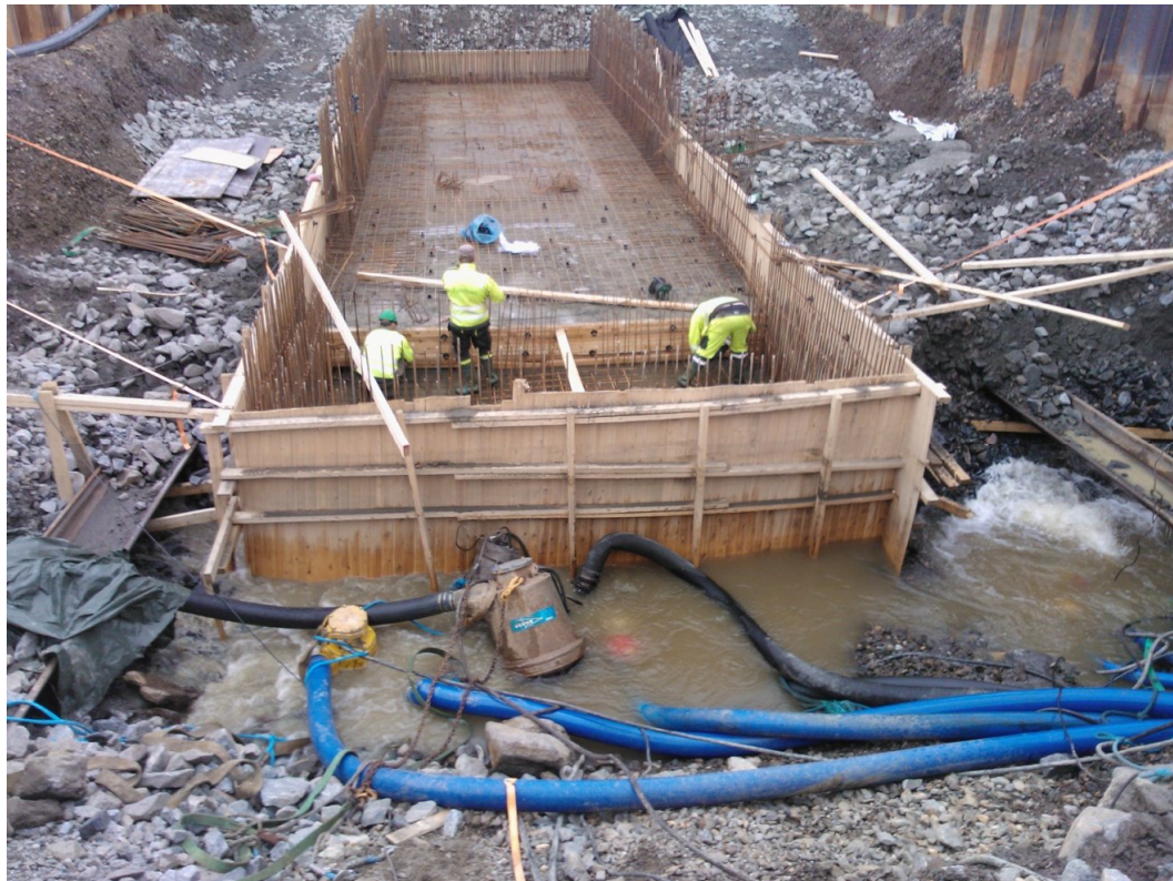
Kuva 12. Muottien ja raudoitusten tekoa. (Männikkö 2012-09-05)
