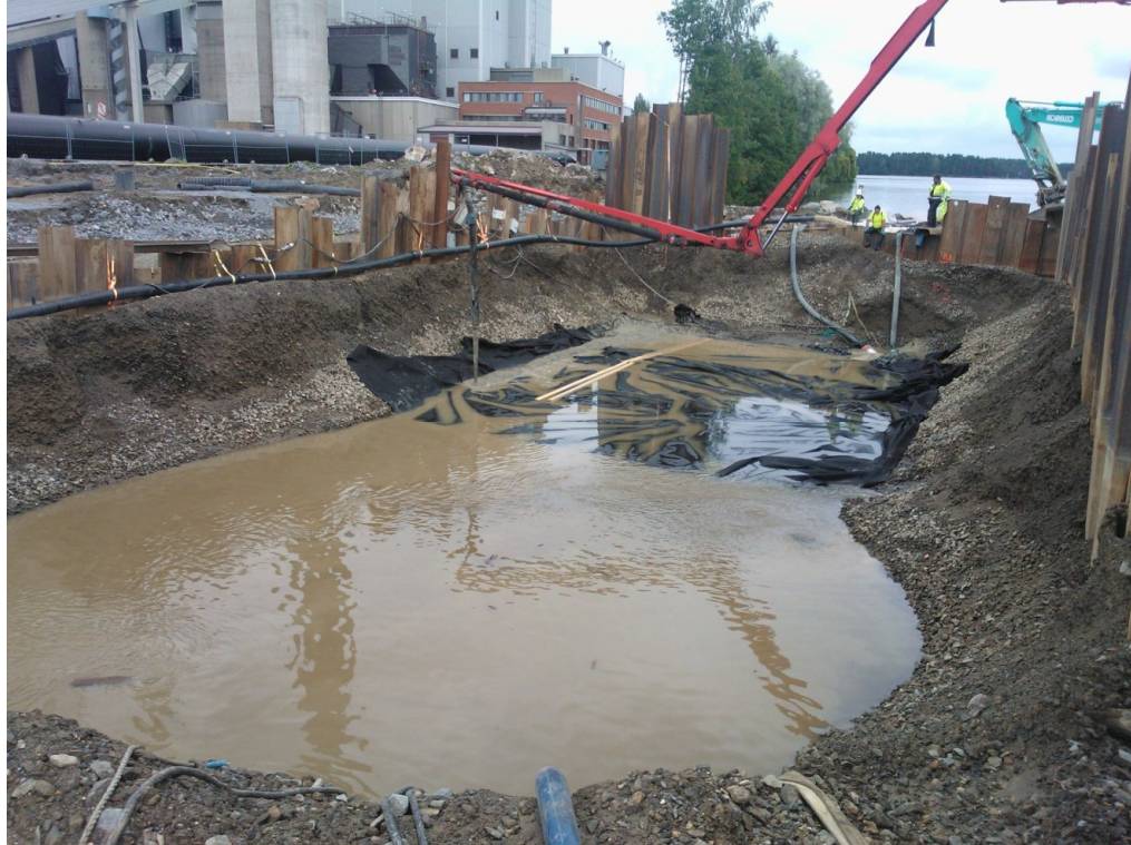
Kuva 10. Maanvaraisen betonilaatan valu (Männikkö 2012–08–24)
