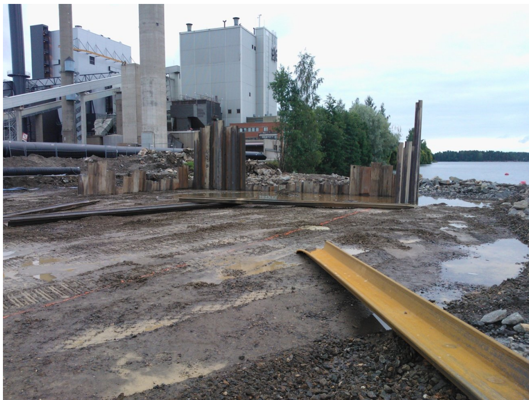
Kuva 7. Osa ponteista pysähtyi isoihin kiviin. (Männikkö 2012-08-10)
