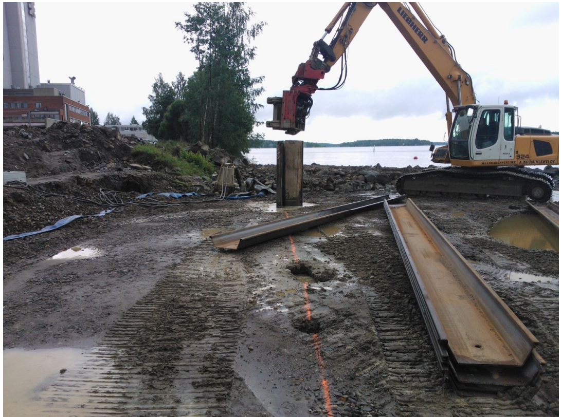
Kuva 5. Ponttaus aloitettu. (Männikkö 2012–08–09)
