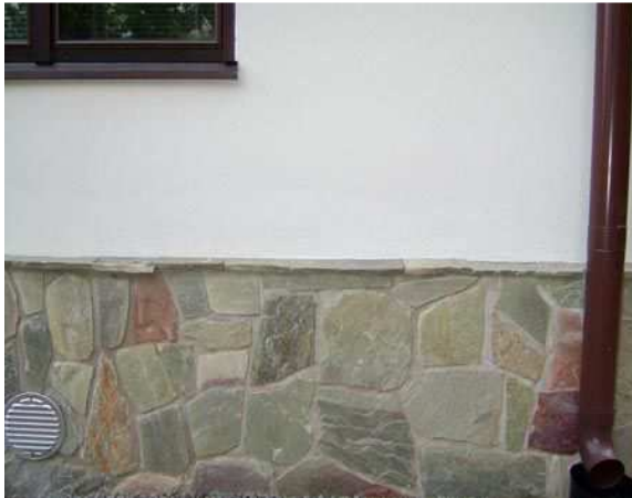
Kuva 8. Luonnonkivellä päällystetty sokkeli, esimerkki 1. (Ikikivi, 2013)
