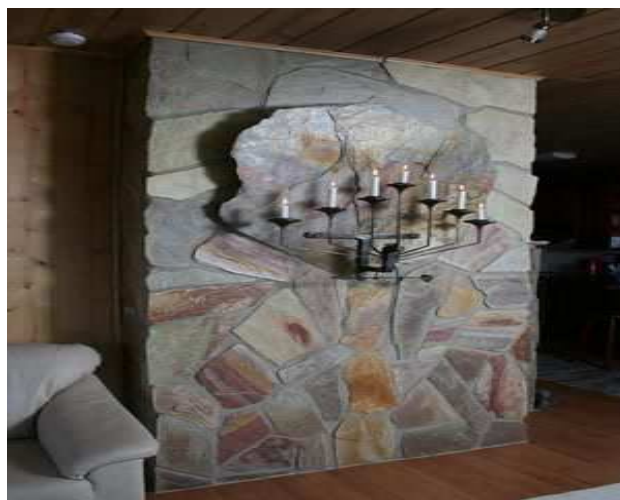
Kuva 17. Liuskekivellä päällystetty seinä. (Ikikivi, 2013)
