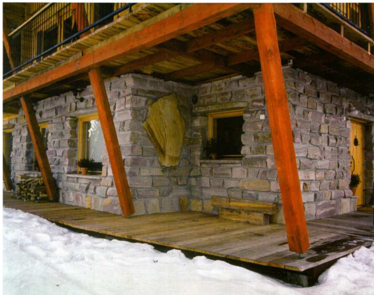
Kuva 10. Luonnonkivestä muurattu julkisivu. (Raatikainen, 2013)
