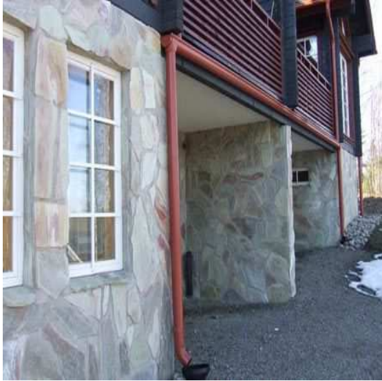
Kuva 11. Ikkunoiden pielet tehty kokonaan kivistä. Kuva 12. Kiven ja pellin yhdistelmä. (Ikikivi, 2013) (Ikikivi, 2013)
