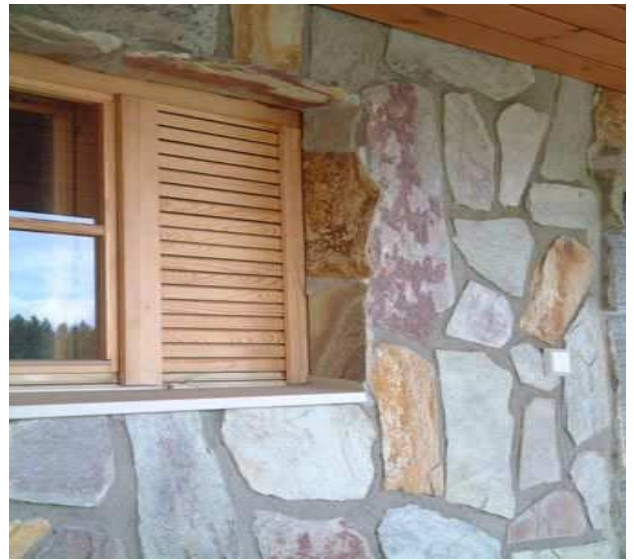
Kuva 11. Ikkunoiden pielet tehty kokonaan kivistä. Kuva 12. Kiven ja pellin yhdistelmä. (Ikikivi, 2013) (Ikikivi, 2013)
