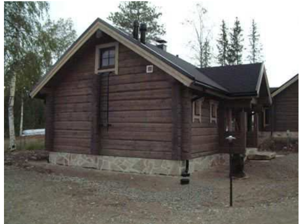
Kuva 9. Luonnonkivellä päällystetty sokkeli, esimerkki 2. (Ikikivi, 2013)
