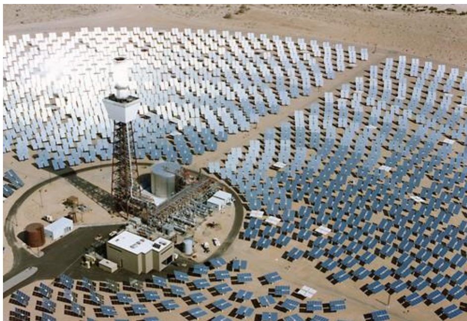
Kuva 4. SolarReserven voimalaitos Nevadassa /8/.
