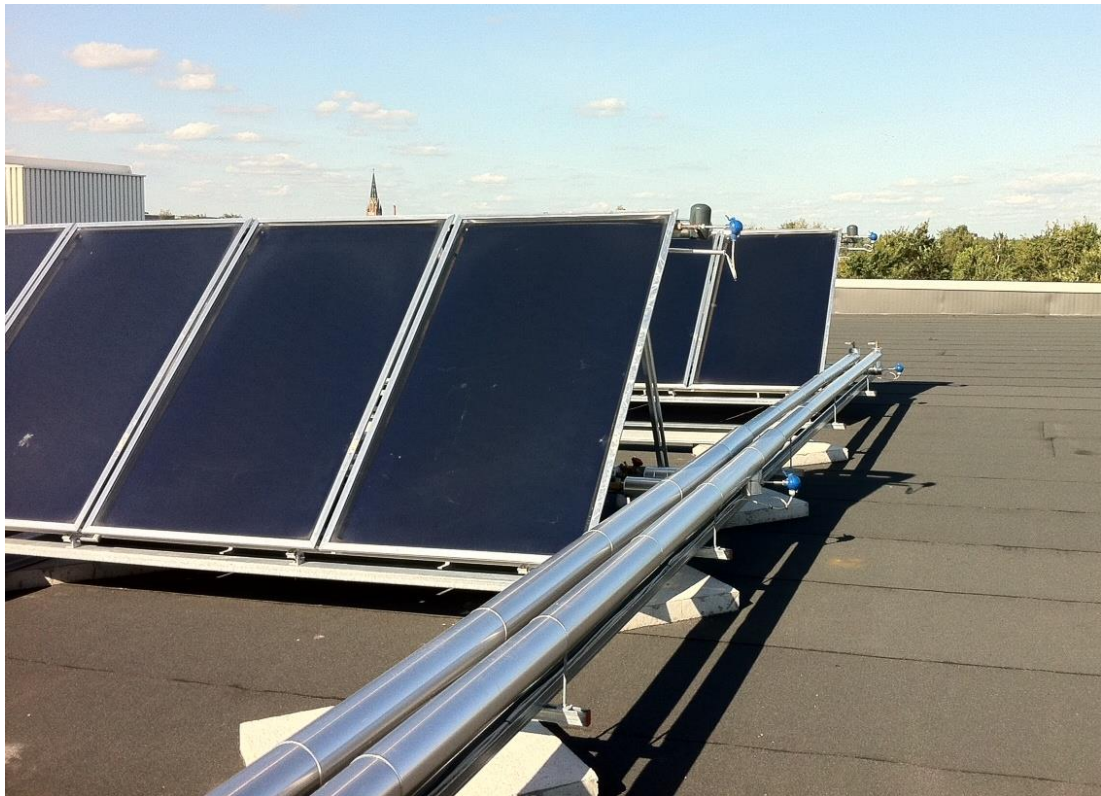
Kuva 13. Porin uimahallin tasokeräimiä. Kuva Nico Haavisto.
