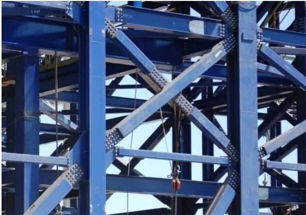
Figure 2: Cross Bracing (Vänttinen 2012, 28.)
