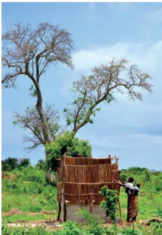
KUVA 2. Paikallinen perheenäiti rakentaa käymälän seiiniä (kuva Juha Ojala)
