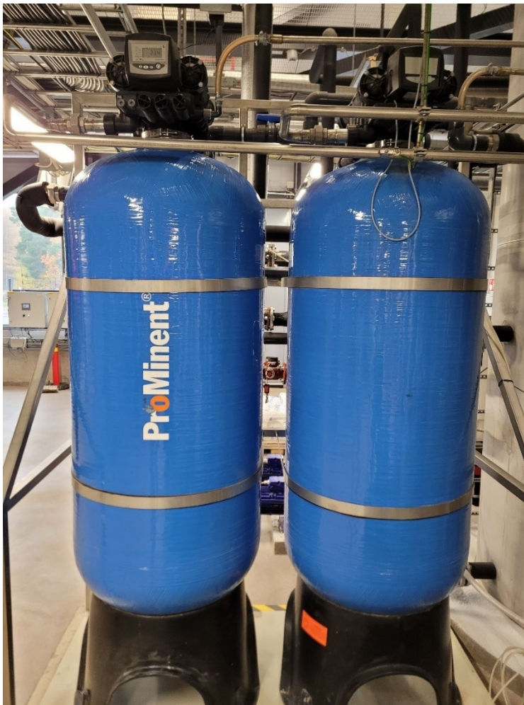
Kuva 3. Artukaisten pehmennyssuodattimet.
