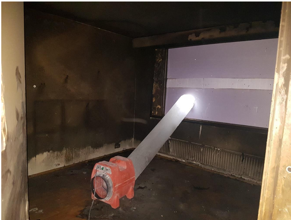
Kuva 6. Palopurkutöitä on valmiina alkamaan (Rantala 2020)
