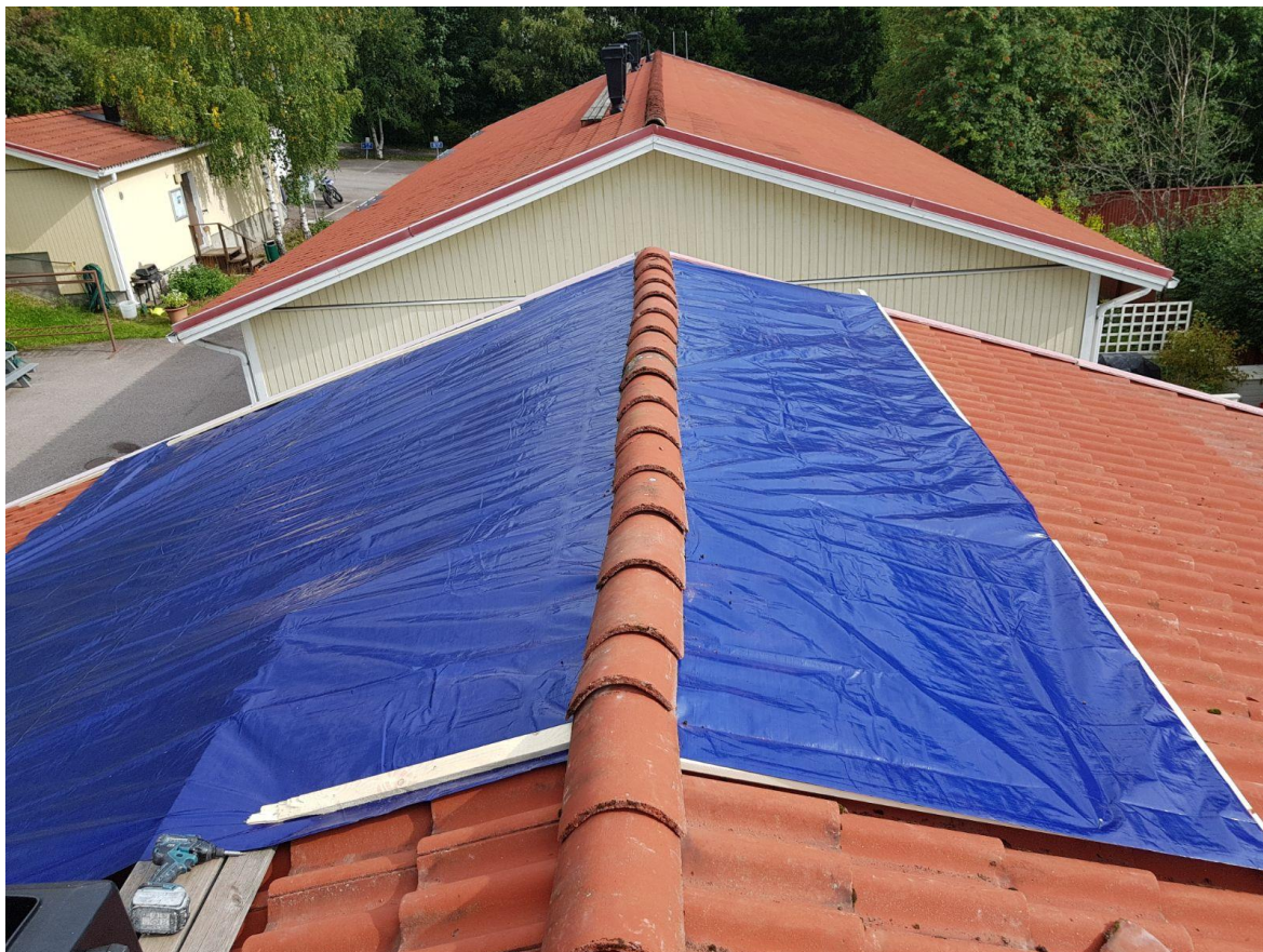
Kuva 5. Vesikattorakennetta on suojattu jälkivahingontorjuntatöiden yhteydessä (Rantala 2017)
