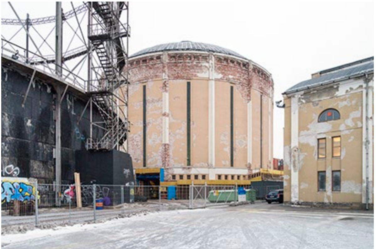
Kuva 14. Keskellä tiilinen kaasukello ja vasemmalla metallinen. Kuva Sakari Kiuru
