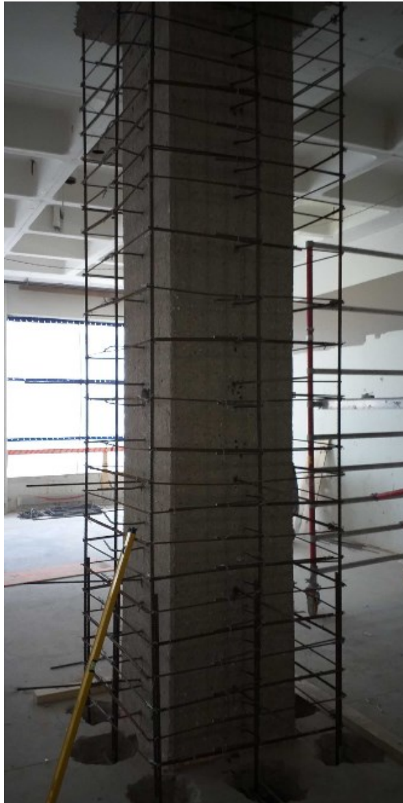
Kuva 14. Raudoitettu vanha pilari ennen muottia ja manttelointivalua. Kuva otettu Siltasaari 10-hankkeen työmaalla S6 lohkon 1 kerroksessa.
