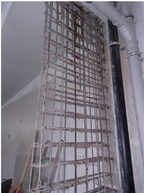
Kuva 15. Raudoitettu IV-aukon jäykistävä seinä ennen muotitusta. Kuva otettu Siltasaari 10-hankkeen työmaalla S6 lohkon 1 kerroksessa.
