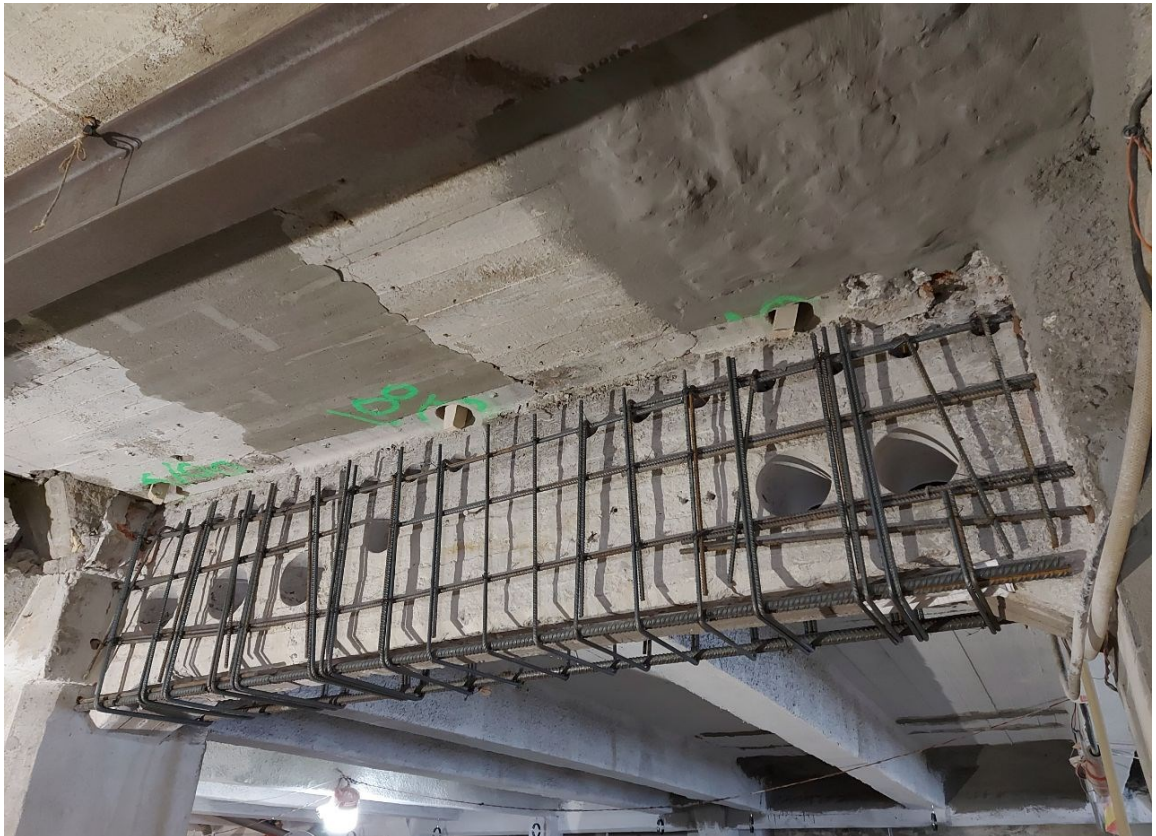
Kuva 13. Raudoitettu vanha teräsbetonipalkki ennen muottia ja manttelointivalua. Kuva otettu Siltaasaari 10- hankkeen työmaalla S8 lohkon kellarissa.
