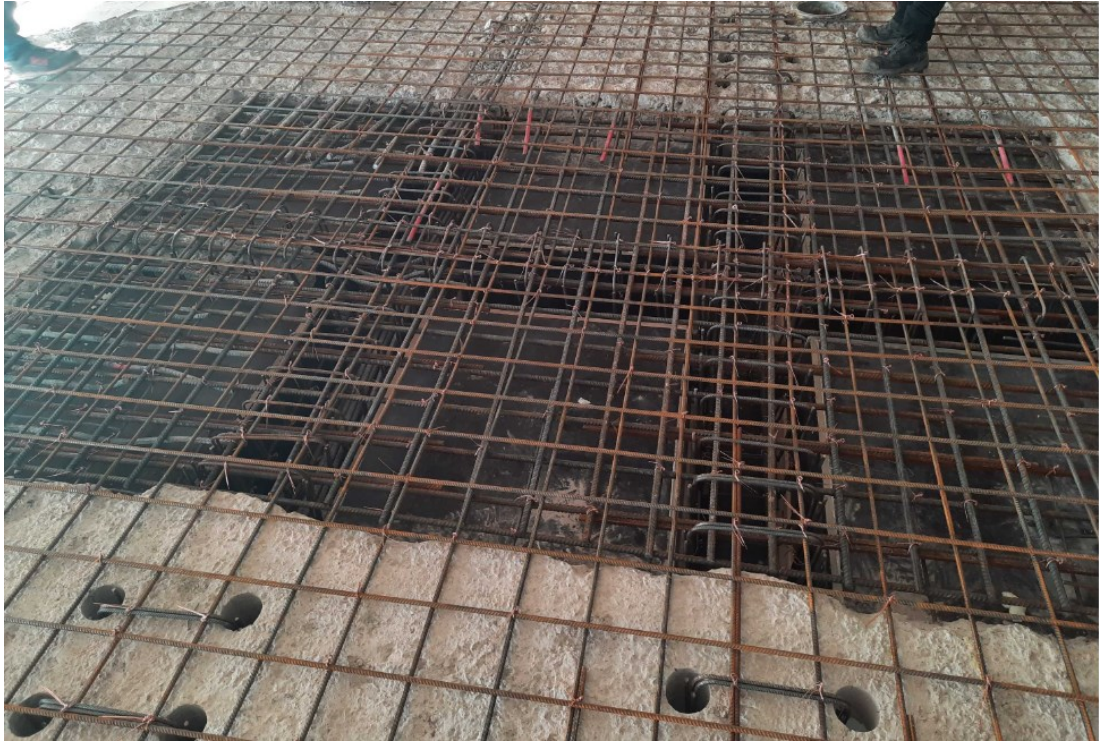
Kuva 16. Raudoitettu vanha purkujätteen pudotusaukko ennen manttelointivalua. Muotti on tehty holvin alapuolelta 2 kerroksesta. Kuva otettu Siltasaari 10- hankkeen työmaalla S6 lohkon 3 kerroksessa.
