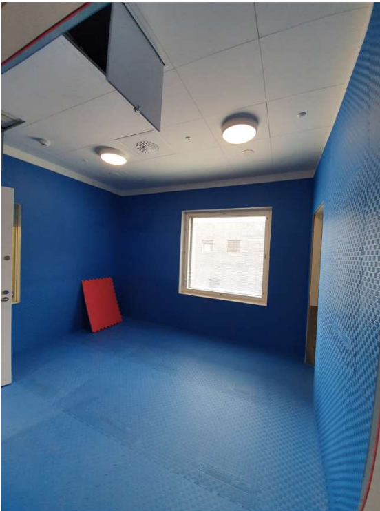
Kuva 8. Esimerkkikohteen eristyshuone rakennusvaiheessa (Granlund & Ramboll, 2020).
