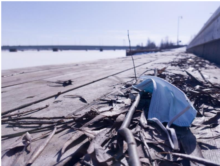
Kuva 12 Tornion Nordbergin Möljän rantalaituri tasanteella.
