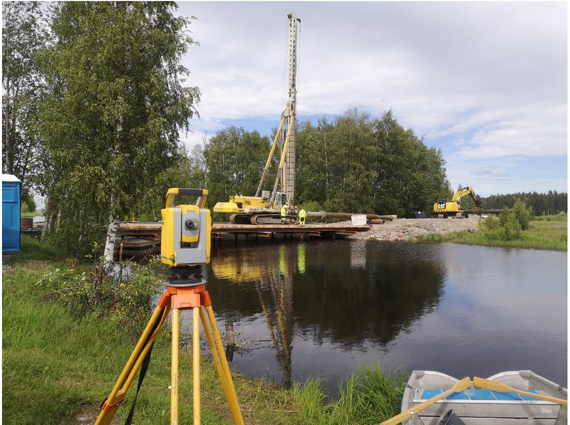
Kuva 4. Paalutuskone ja takymetri
