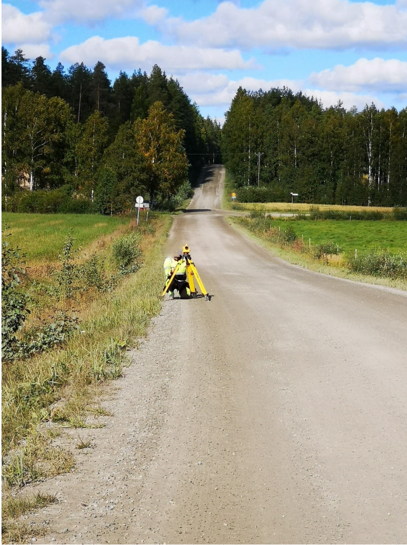
Kuva 1. Vaaitusta hiekkatiellä
