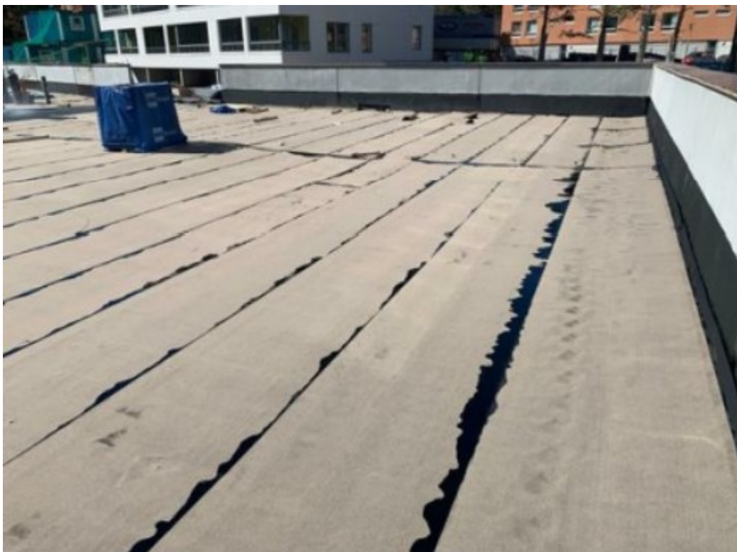
Kuva 4. Pohjakermi asennettu liimaamalla (Kuva: Samuli Viitala)
