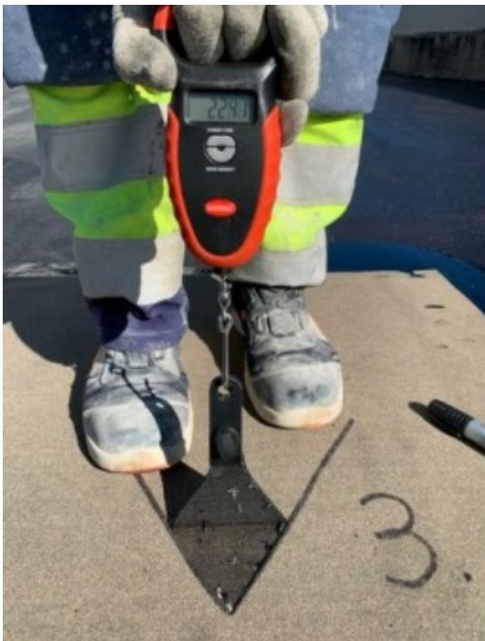
Kuva 12. Bitumikermieristyksen tartuntakoe (Kuva: Samuli Viitala)
