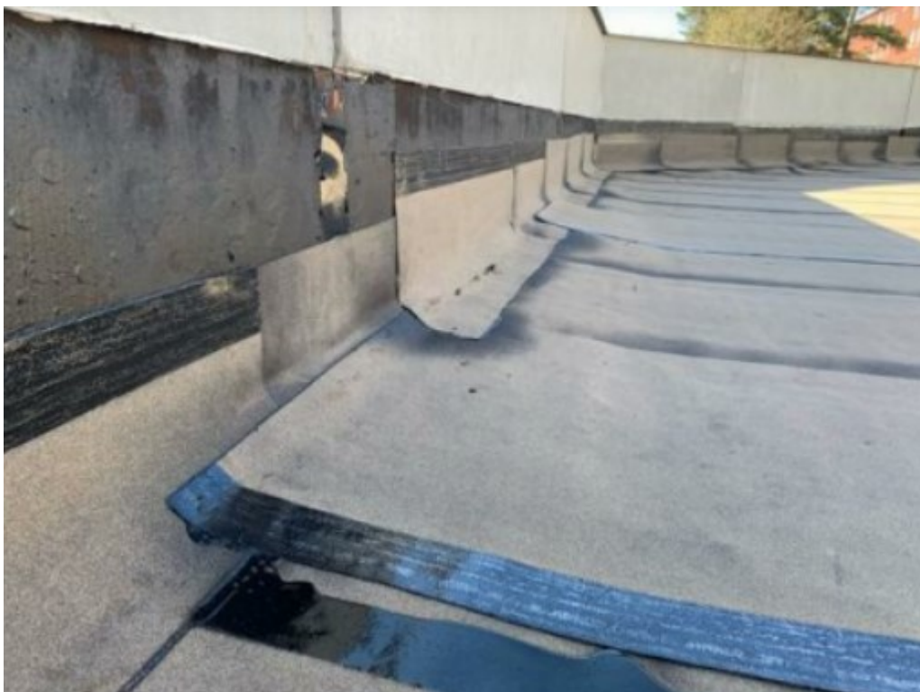
Kuva 6. Kermieristyksen ylösnosto (Kuva: Samuli Viitala)
