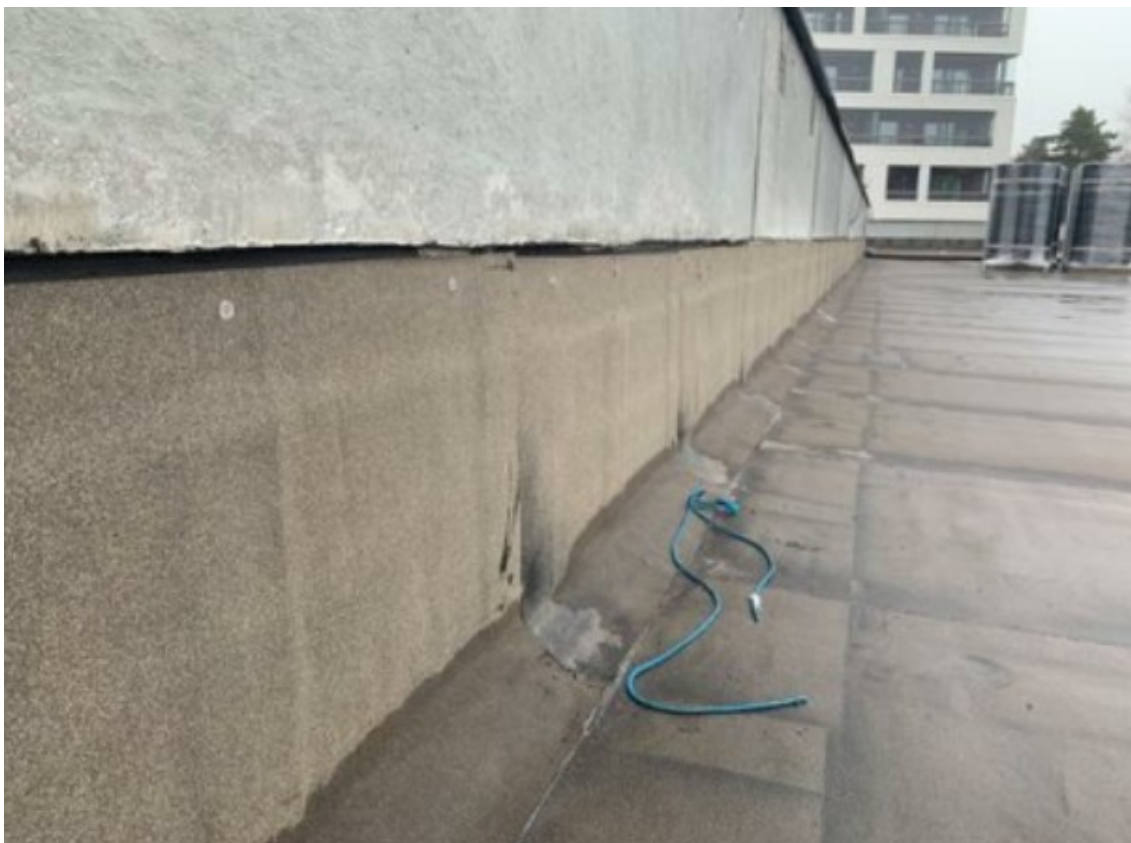
Kuva 7. Bitumikermin ylösnosto (Kuva: Samuli Viitala)
