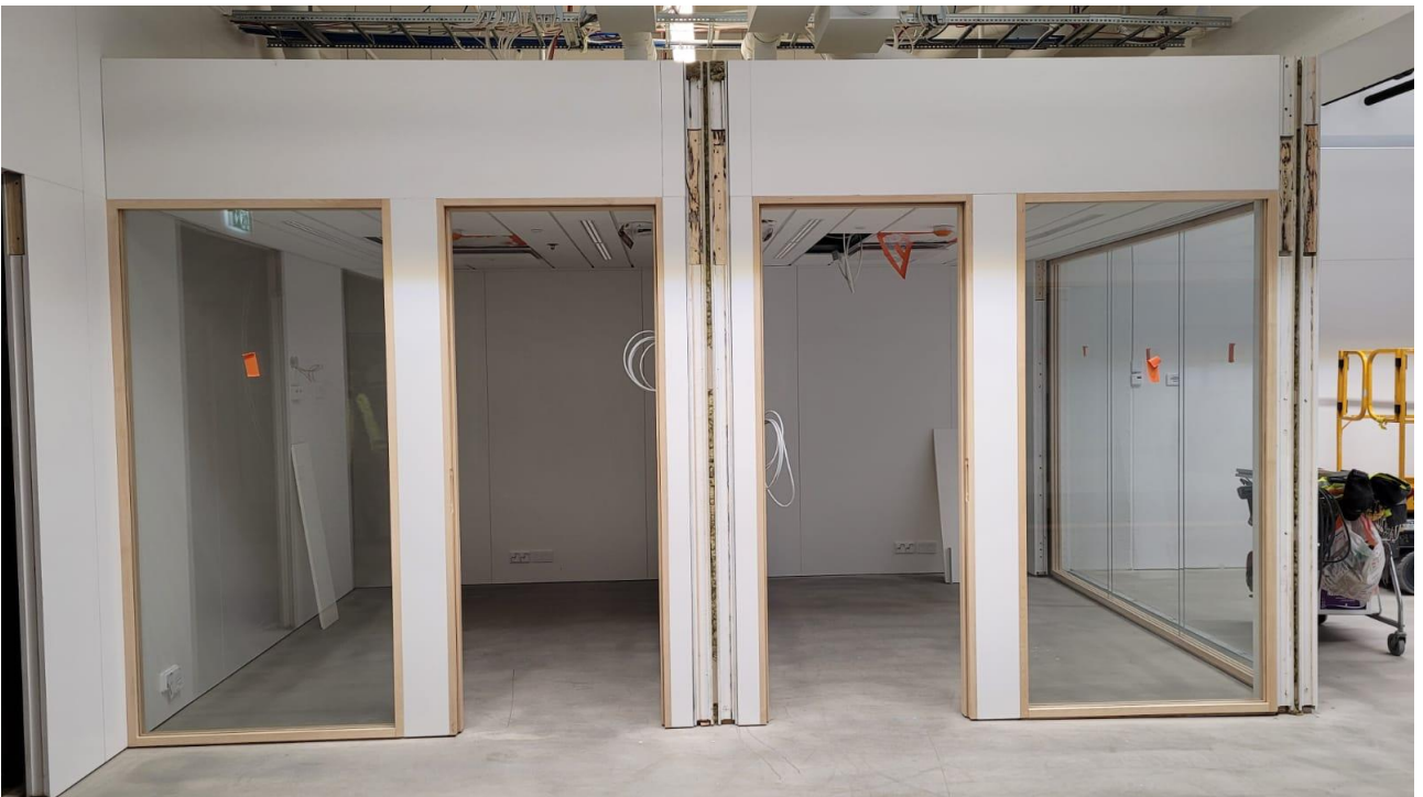
Liite 3 kuva 2 Modular seinä- ja kattoelementeillä toteutettu toimistohuone
