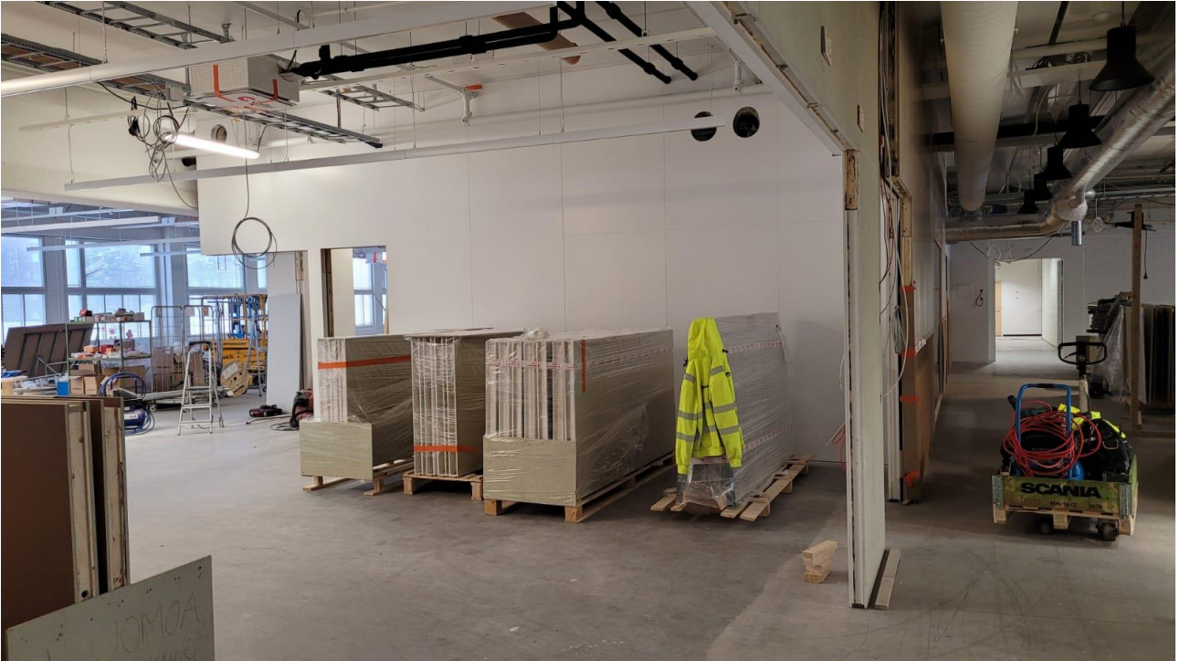
Kuva 3 Pakattuja elementtejä odottamassa asentamista
