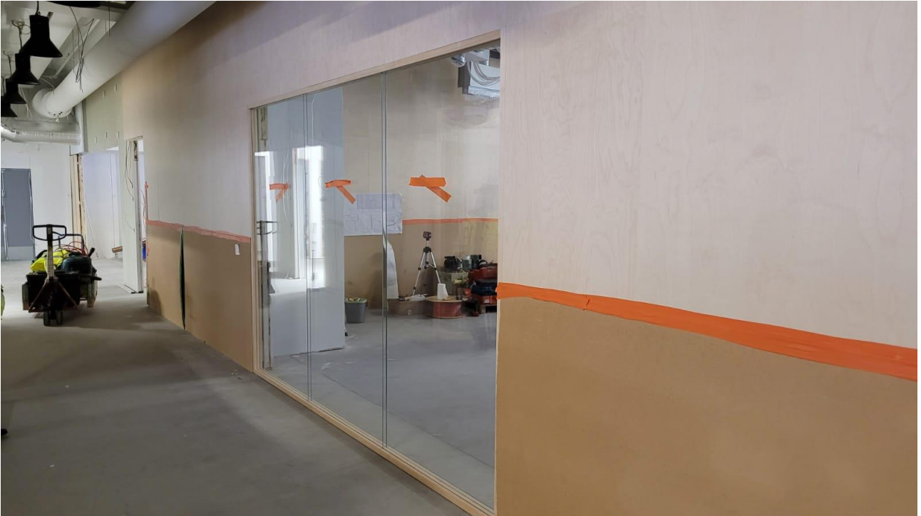
Liite 3 kuva 1 Valmista seinää, jossa rakennusaikainen suojapahvi paikallaan
