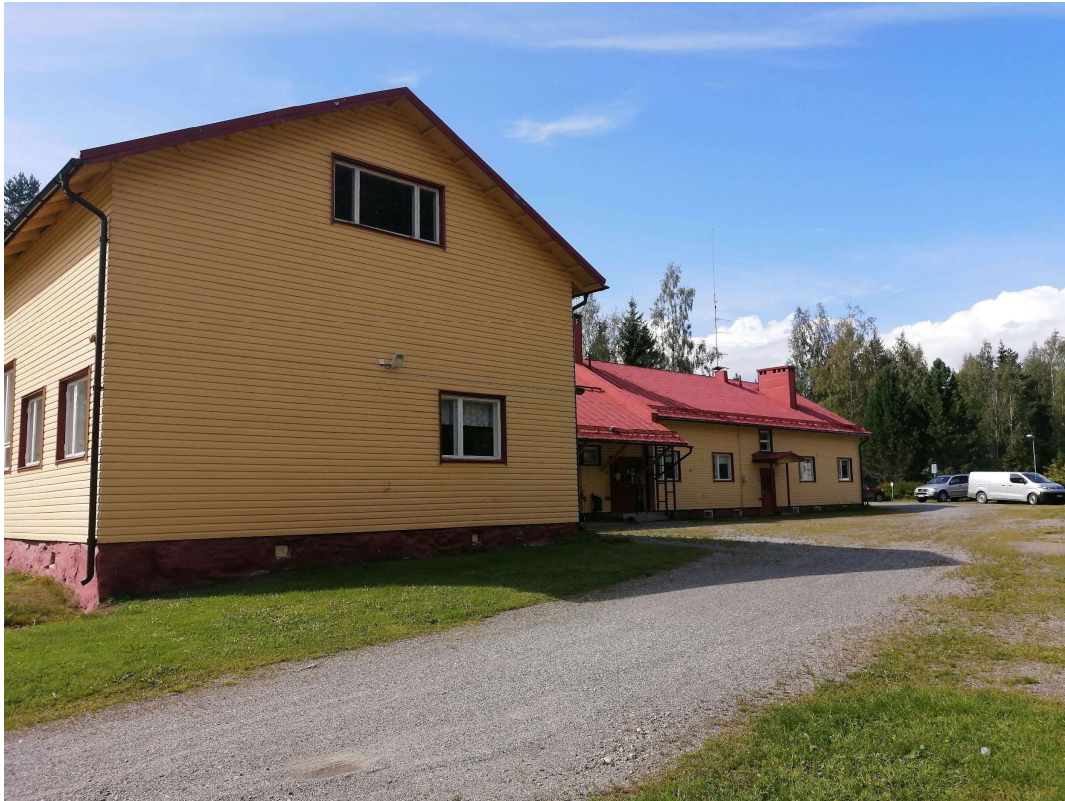
KUVA 8. Konnuslahden koulu. Etualalla vanha osa, joka on rakennettu 1900-luvun alussa
