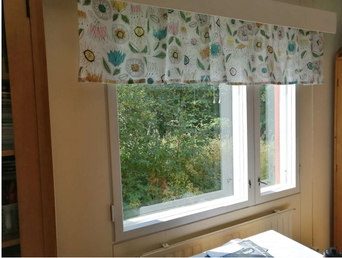
KUVA 17. Konnuslahden koulun ikkunat ovat alkuperäisiä
