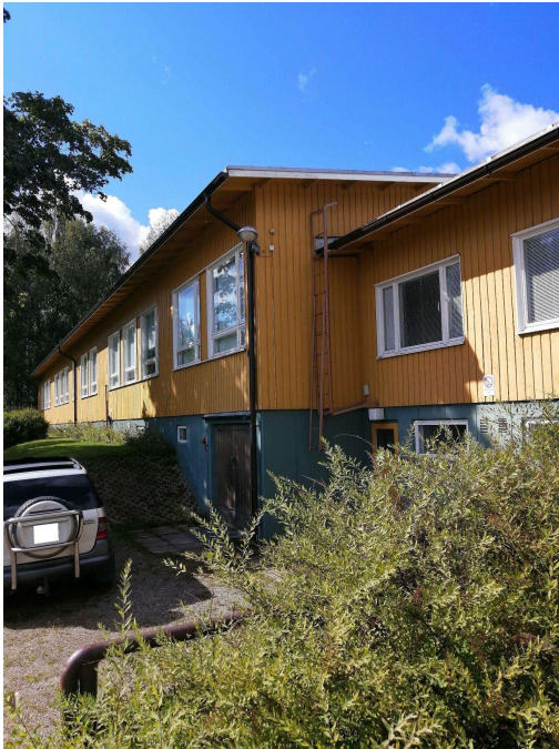
KUVA 13. Ensimmäisen kerroksen julkisivut ovat puuverhoiltuja, kellarikerroksen betoniperustukset on maalattu
