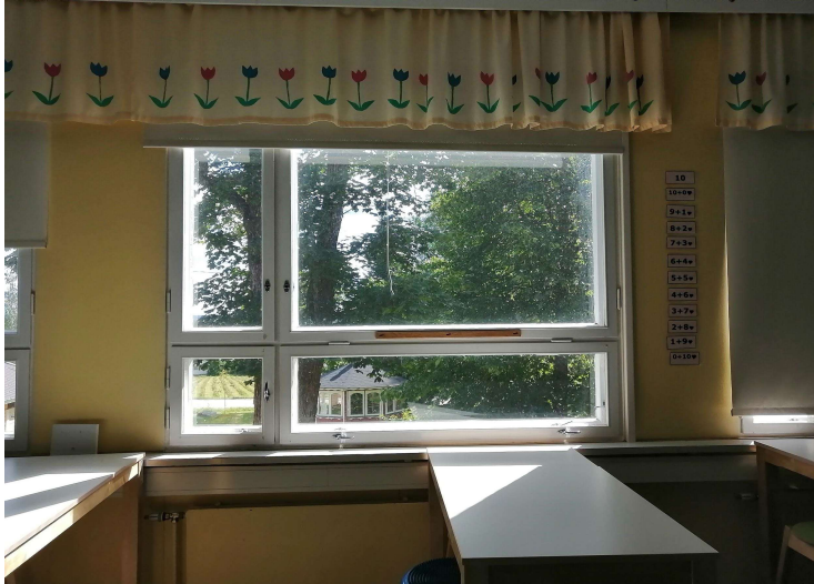
KUVA 14. Kurjalan ikkunoita ei ole uusittu koulun rakentamisen jälkeen
