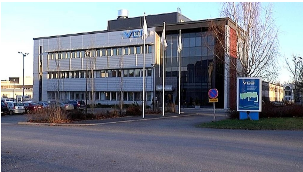
Kuva 1. VEO Oy pääkonttori ja kojeistotehdas.
