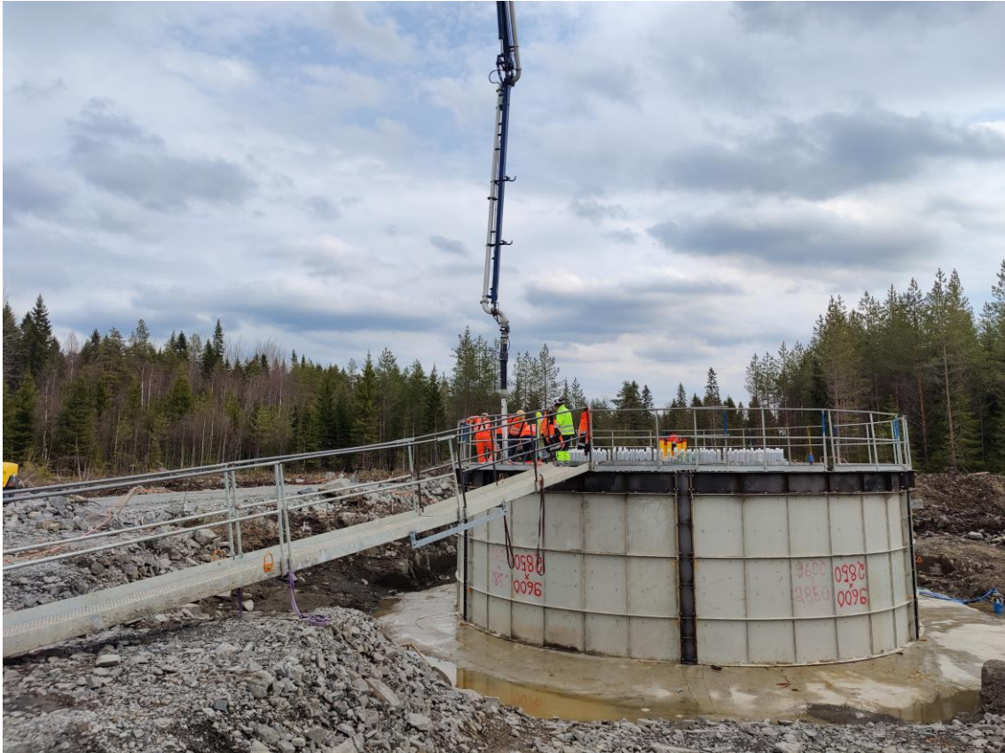
KUVA 5. Kallioankkuroidun perustuksen betonivalu Karhunnevakankaalla
