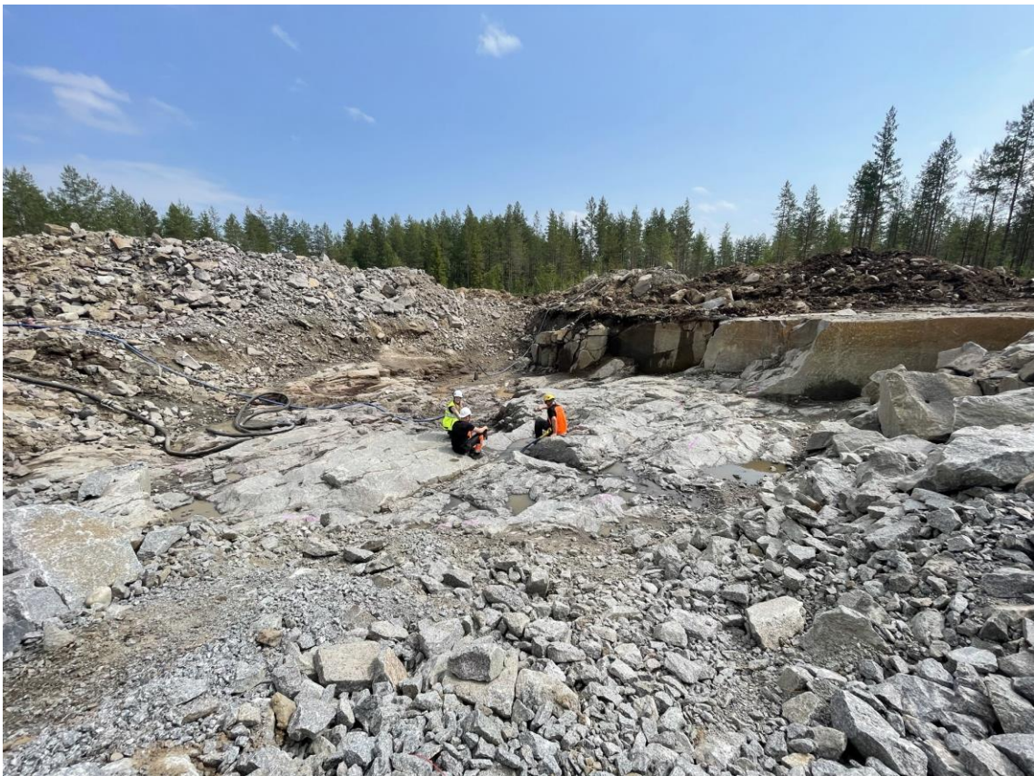
KUVA 4. Kalliovaraisen perustuksen pinta ennen työvalua Karhunnevan kankaalla
