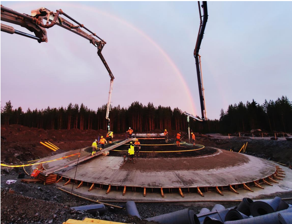
KUVA 3. Maanvaraisen perustuksen betonivalu Karhunnevanankaalla
