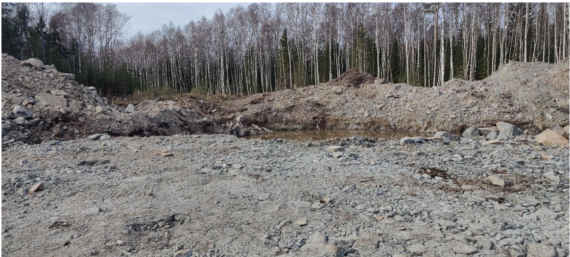
KUVA 8. Malliesimerkki MVR-mittauksessa tehdystä puutteesta: putoamissuoja puuttuu
