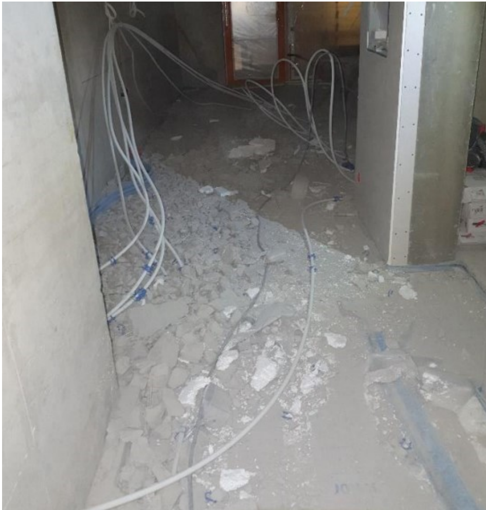
Kuva 12. Purkutyöt käynnissä vesivuodon jälkeen. Kuva: YIT.
