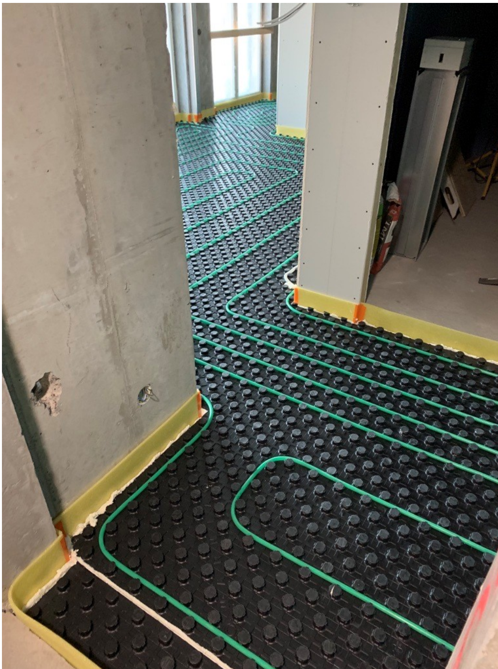
Kuva 10. Valuvalmis lattialämmitysrakenne. Kuva: YIT.
