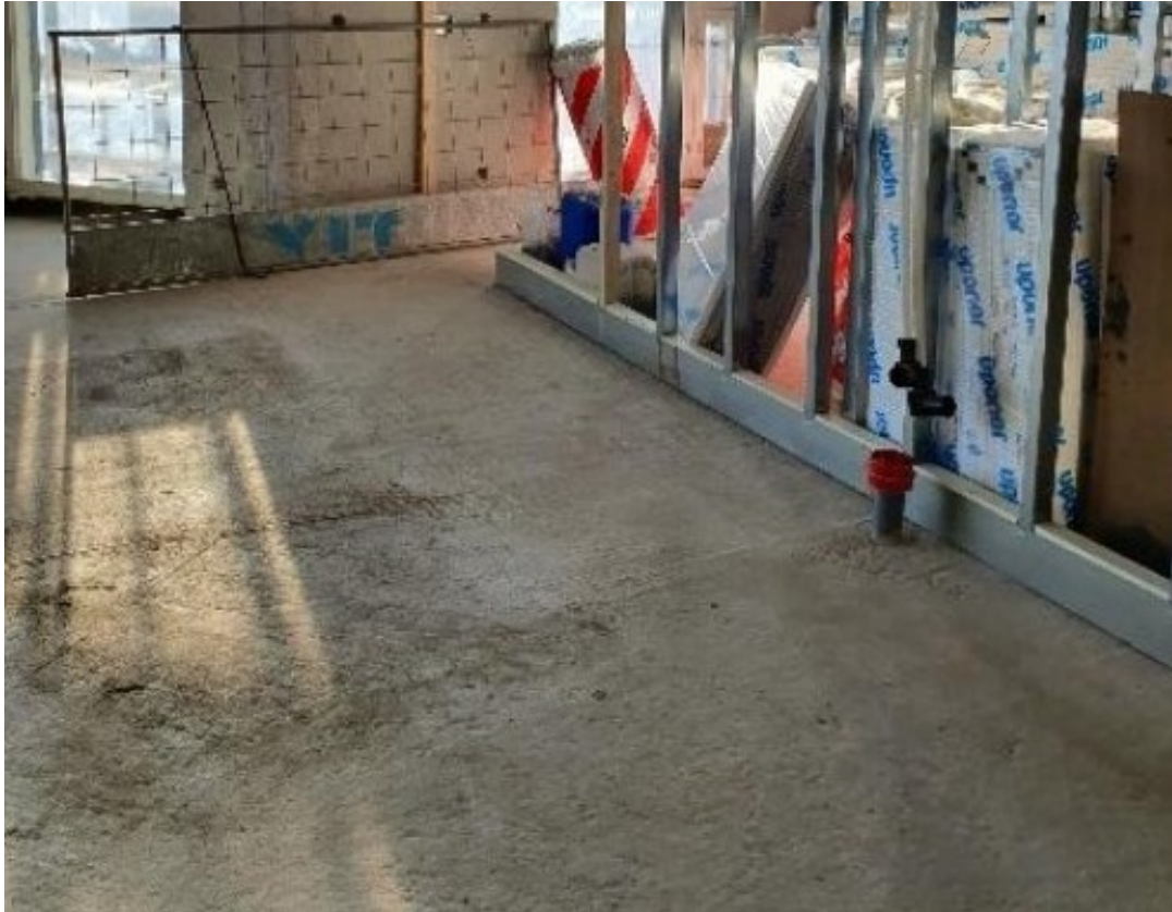
Kuva 8. Lattialämmityksen asennus alkamassa. Kuva: YIT.
