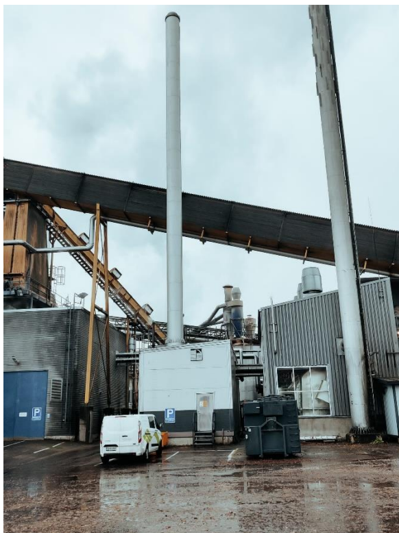
Kuva 4. Voimalaitoksen syklonit kuvassa keskellä takana
