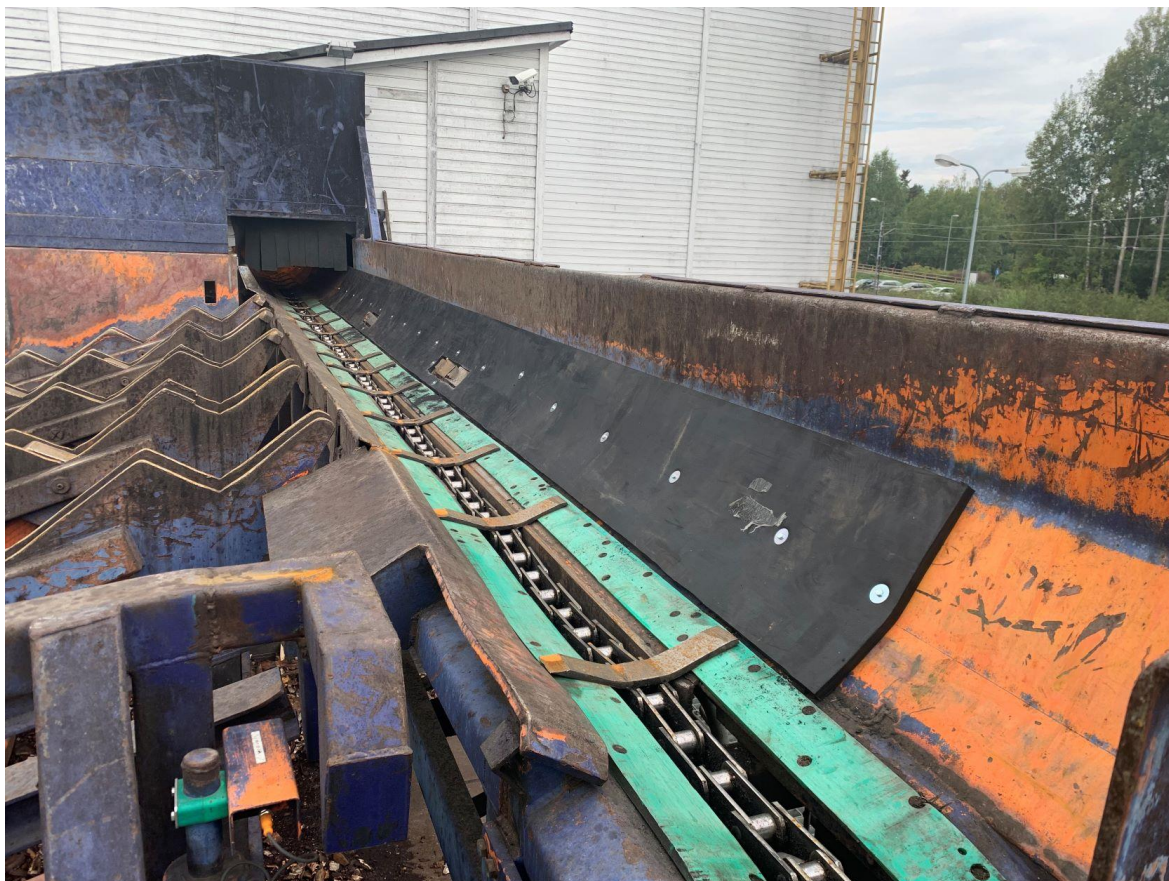
Kuva 3. Tukkikuljettimen vaimennus vaimennuskumilla.
