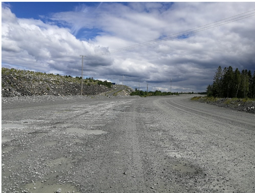
KUVA 3. Oikealla tyhjällä louhosautolla ajettu ja vasemmalla täydellä 140 tonnin kuormalla. (RÖNKÄ 2018-06-30)
