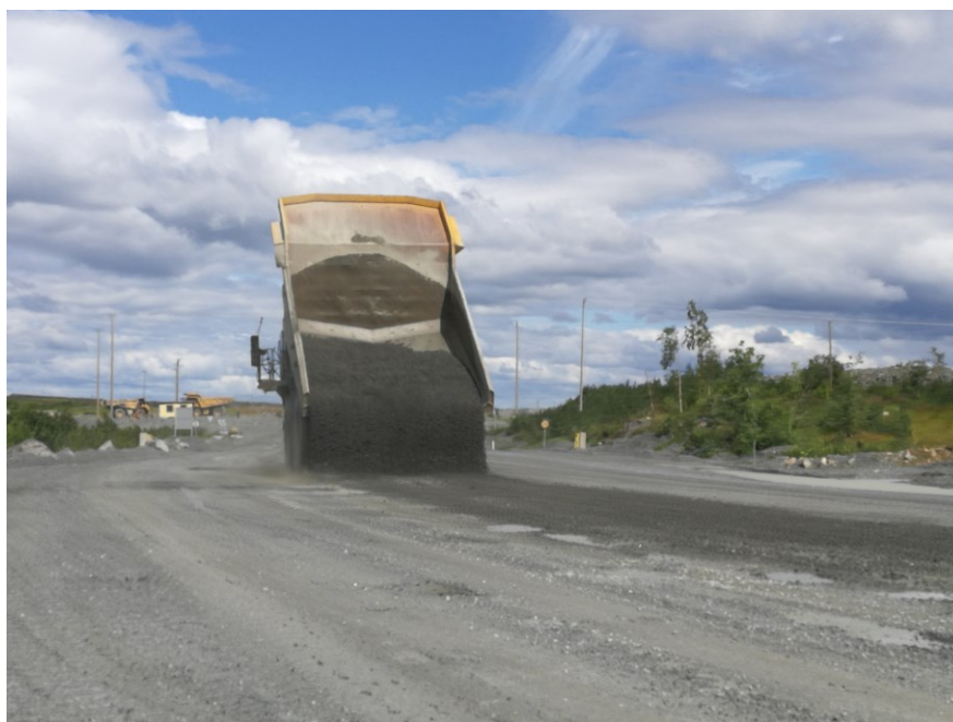
KUVA 6. Murskeen levitys louhosautolla onnistuu ammattitaitoiselta kuljettajalta. (RÖNKÄ 2018-06-30)
