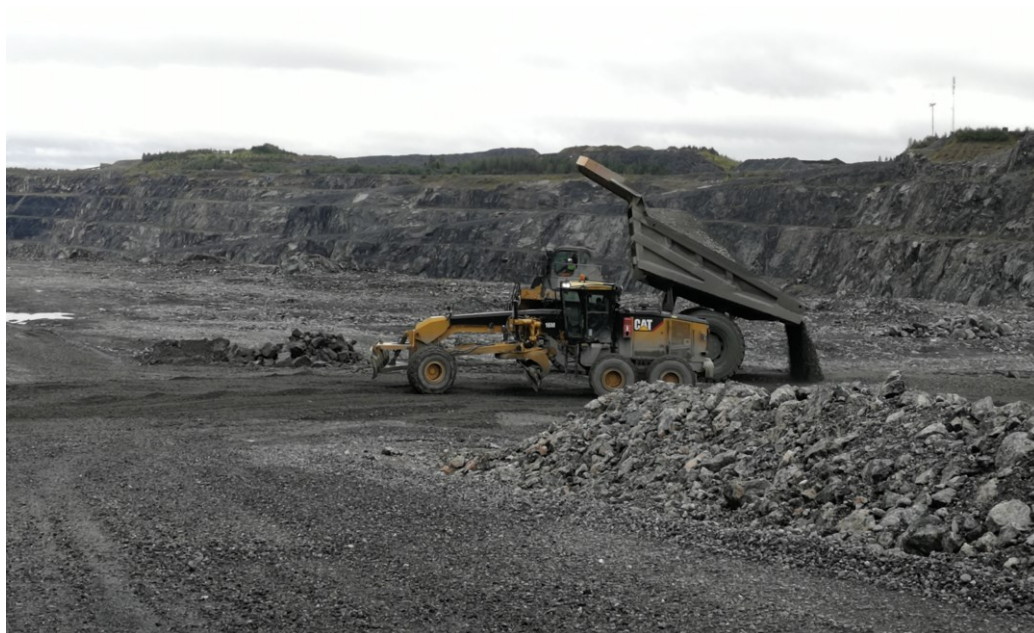
KUVA 5. Tiehöylä vastaanottamassa murskeita koetien osuudelle (RÖNKÄ 2018-09-13)
