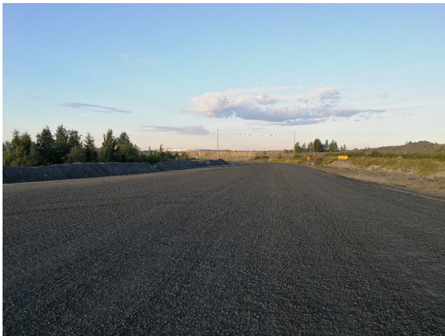
KUVA 8. Louhosten välinen tie mursketuksen ja höyläyksen jälkeen. (RÖNKÄ 2018-06-30)
