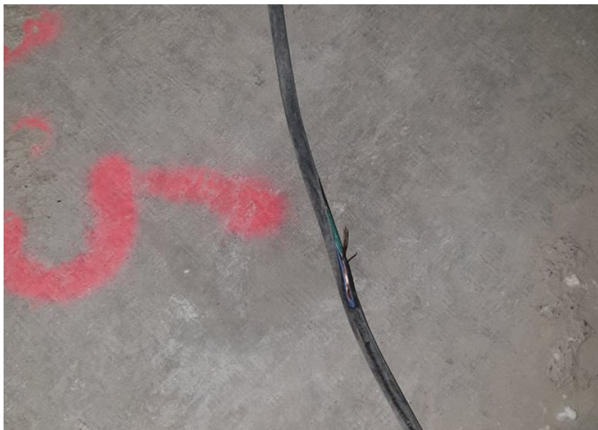
Kuva 8. YIT Vantaan Kurpitsan työmaa
