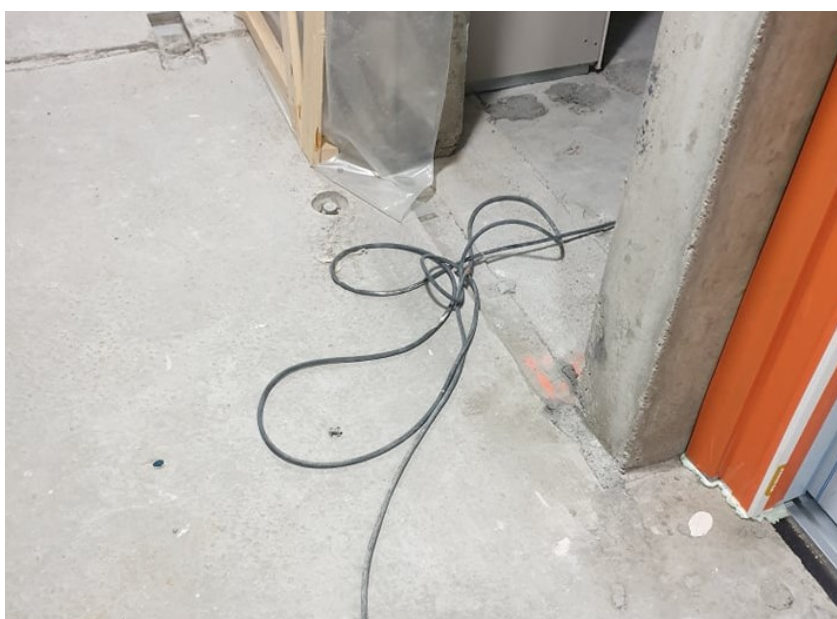
Kuva 7. YIT Vantaan Kurpitsan työmaa
