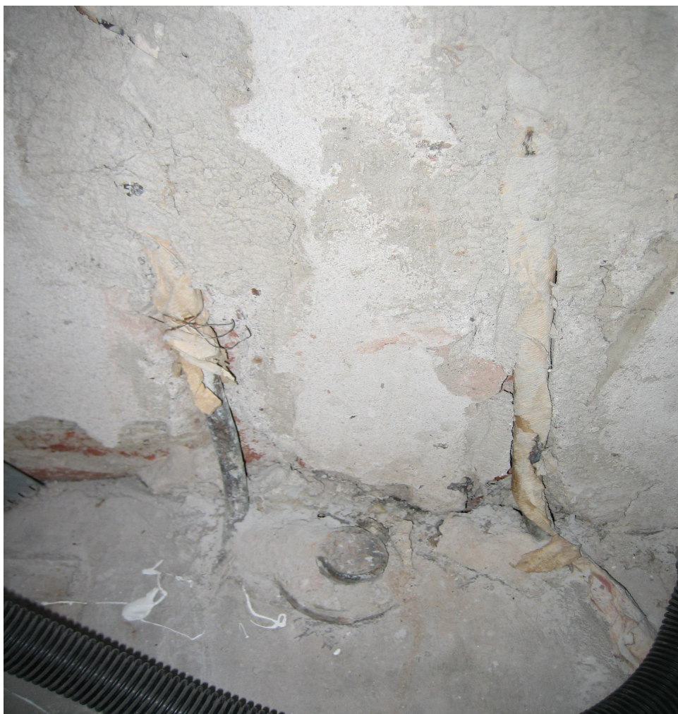
Kuva 5. Märkätilan vesijohdot poistetun ammeen kohdalta. Kylpyhuoneen seinää tasoi- tettiin ja vesijohdot eristettiin, jotta seinä saatiin yhdenmukaiseksi laatoitusta varten. (MAH Isännöinti Oy)
