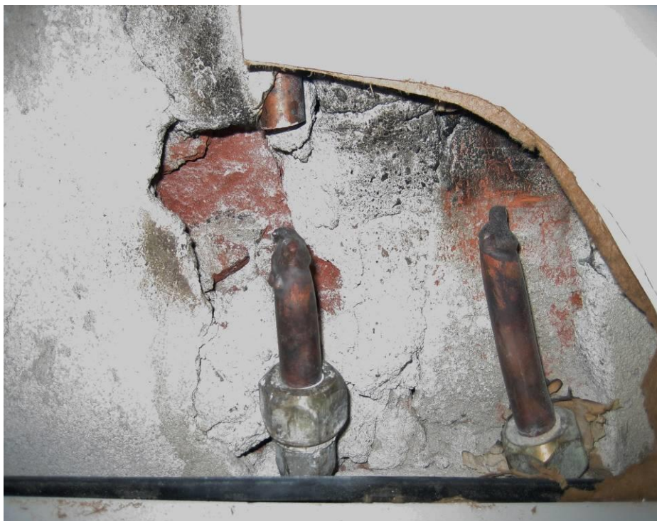
Kuva 4. Tulpattuja vesijohtoja (MAH Isännöinti Oy)
