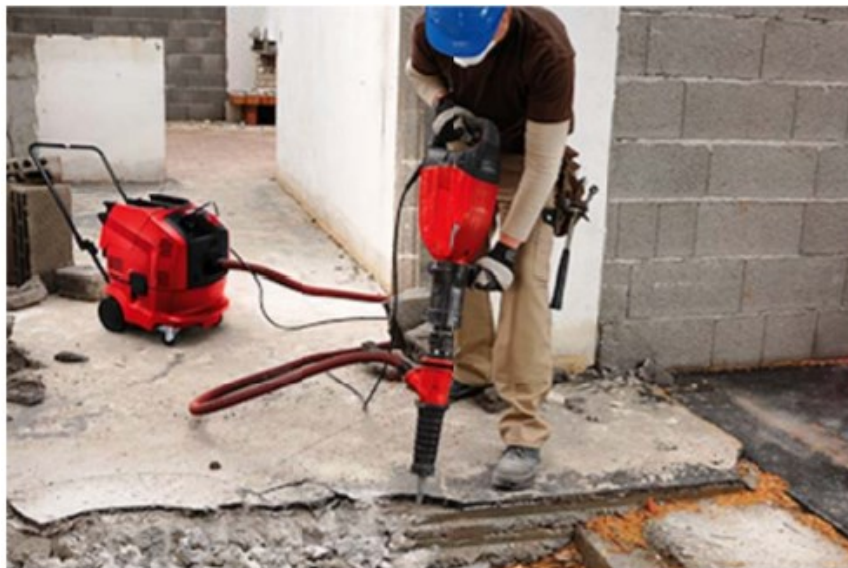
KUVA 8. Kohdepoistoimuri piikkausvasarassa (Koski, Mattila, Taipale 2013)
