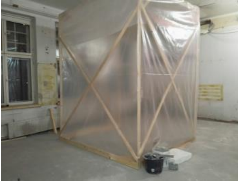
Kuva 2. Passiivinen pölynhallinta ja pilottikohteen osastoitu sekoituspiste.
