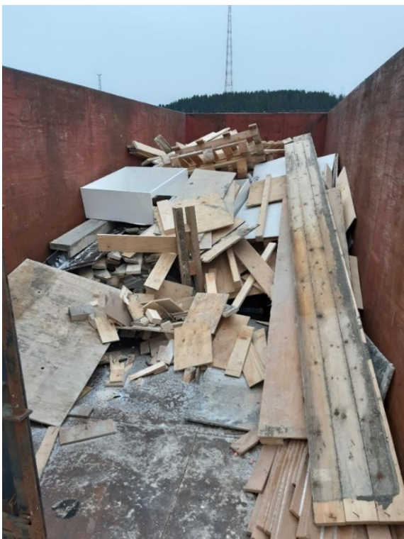
Kuva 7. Sekalaista puuta työmaalla 2020.
