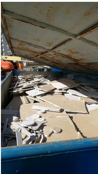
Kuva 10. Kipsilevyä kannellisella keräyslavalla 2020.
