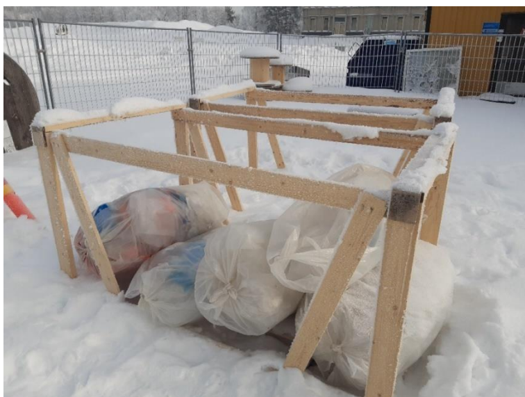
Kuva 13. Säkitettyä kalvomuovia työmaalla 2021.
