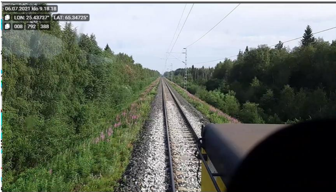
KUVA 7. Uusi sepeli erottuu selvästi vanhaa sepeliä vaaleampana (2)
