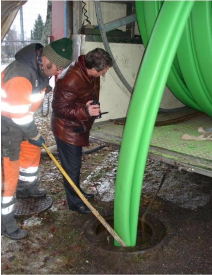
Kuva 24 Muotoputken purku kuljetuskalustosta (FISTT. 2021)
