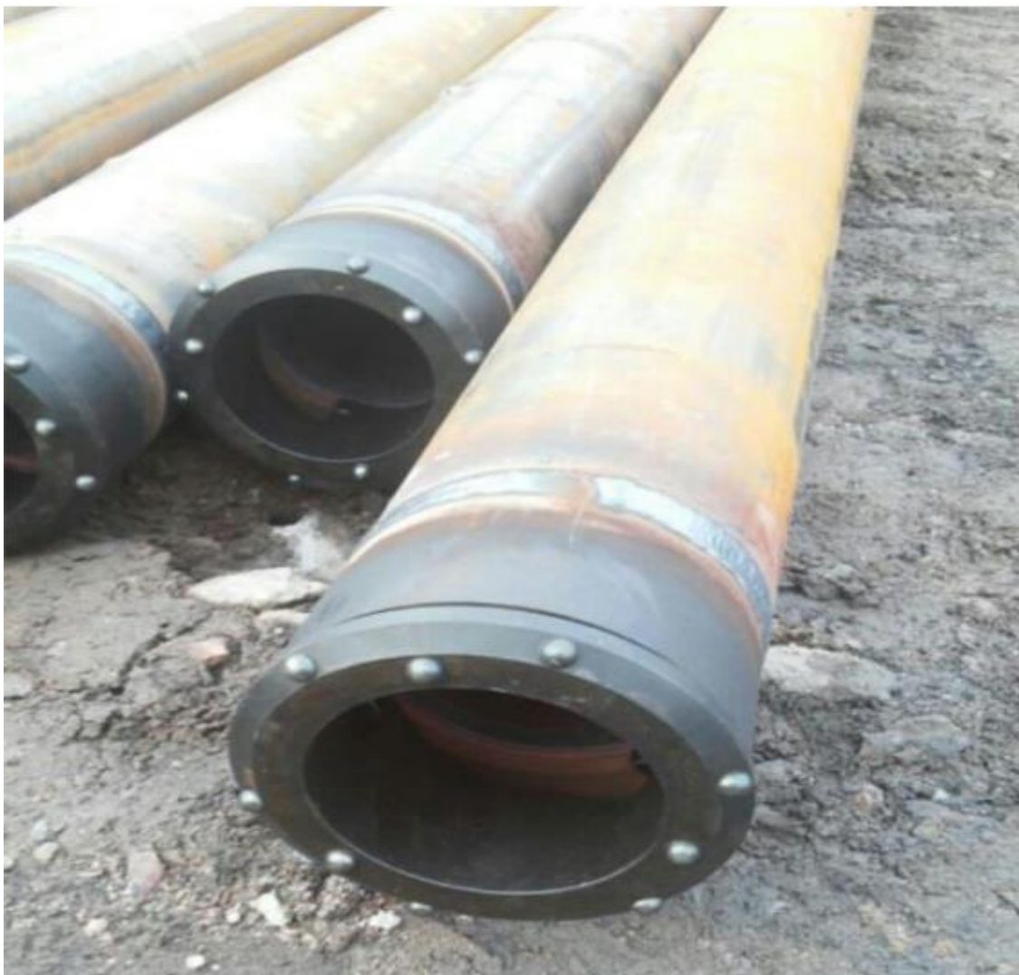
Kuva 14 Rengasterä hitsattuna porapaaluun (kuva Isomäki Antti, s. 17.).
