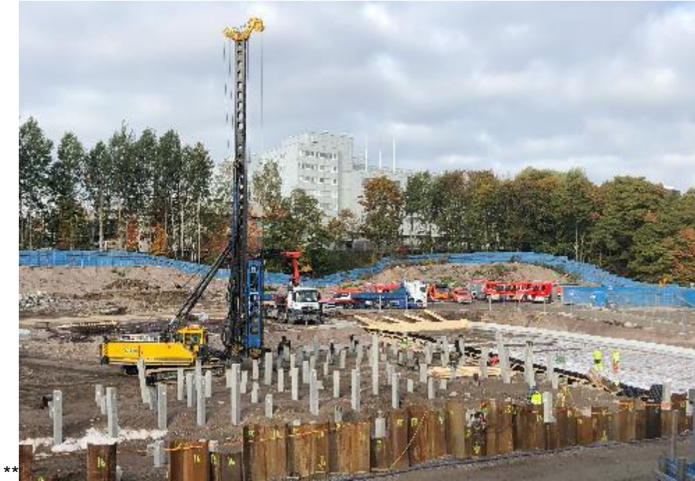
Kuva 4 Teräsbetonipaalutusta Pasilassa. (Kuva: Henri Holmstén, Pasila 2.10.2018.)
