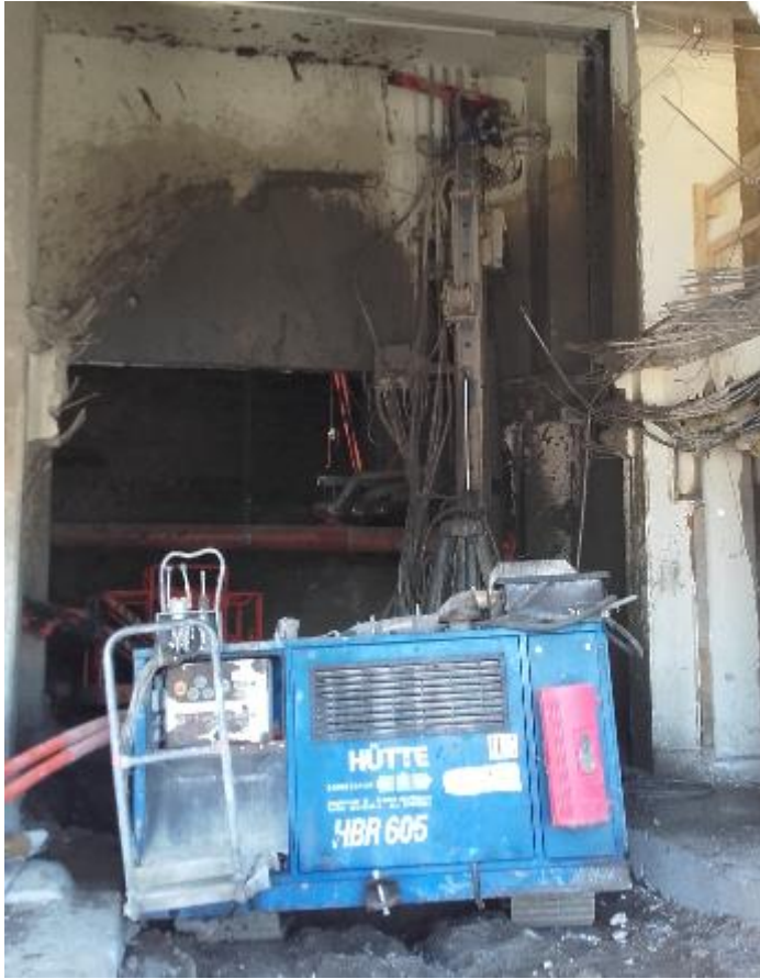
Kuva 11 YIT oma poravaunu Hütte HBR 605, työpaino 15 tonnia. Kuvassa käynnissä RD 406 x 12,5 paalun poraus Pasilan aseman länsipuolen kellaritiloissa (Kuva: Henri Holmstén.)
