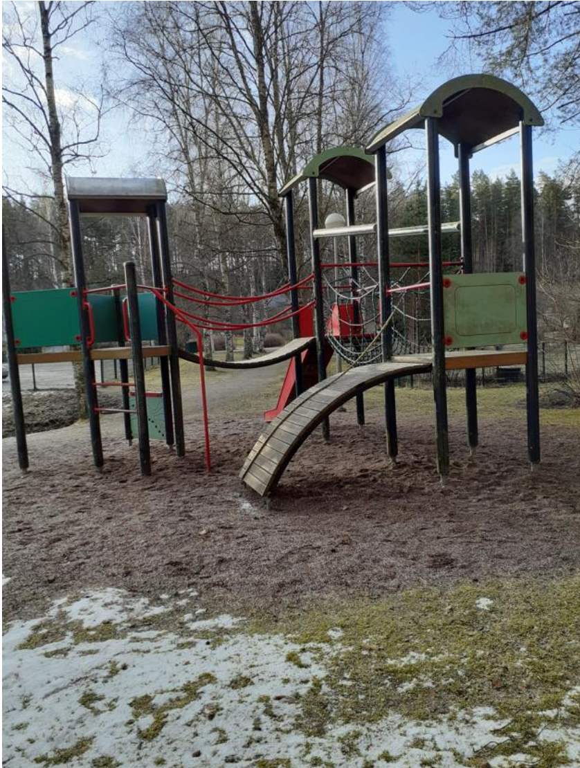
Kuva 13. Sikosuoipuiston leikkialueelta poistettu huonokuntoinen monitoimiteline keväällä 2020 (Eronen, 2020)
