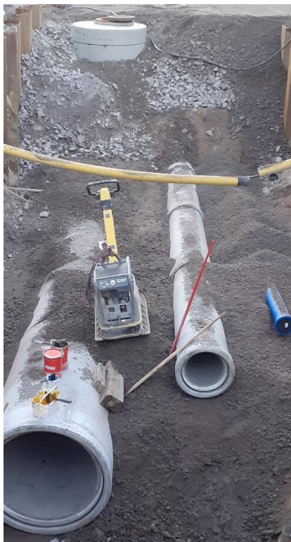
Kuva 11. Hule- ja jätevesiviemärin asennusta (Malin 2021)
