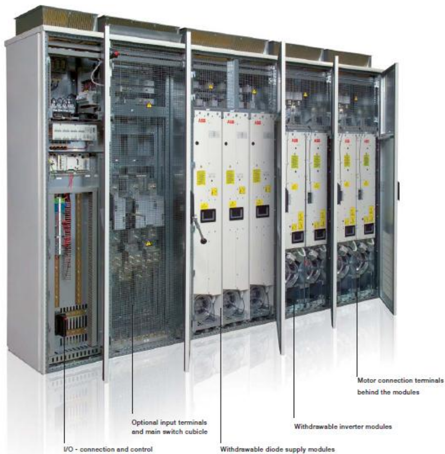
Kuva 24. ACS800-07-taajuusmuuttajan rakenne. /8/
