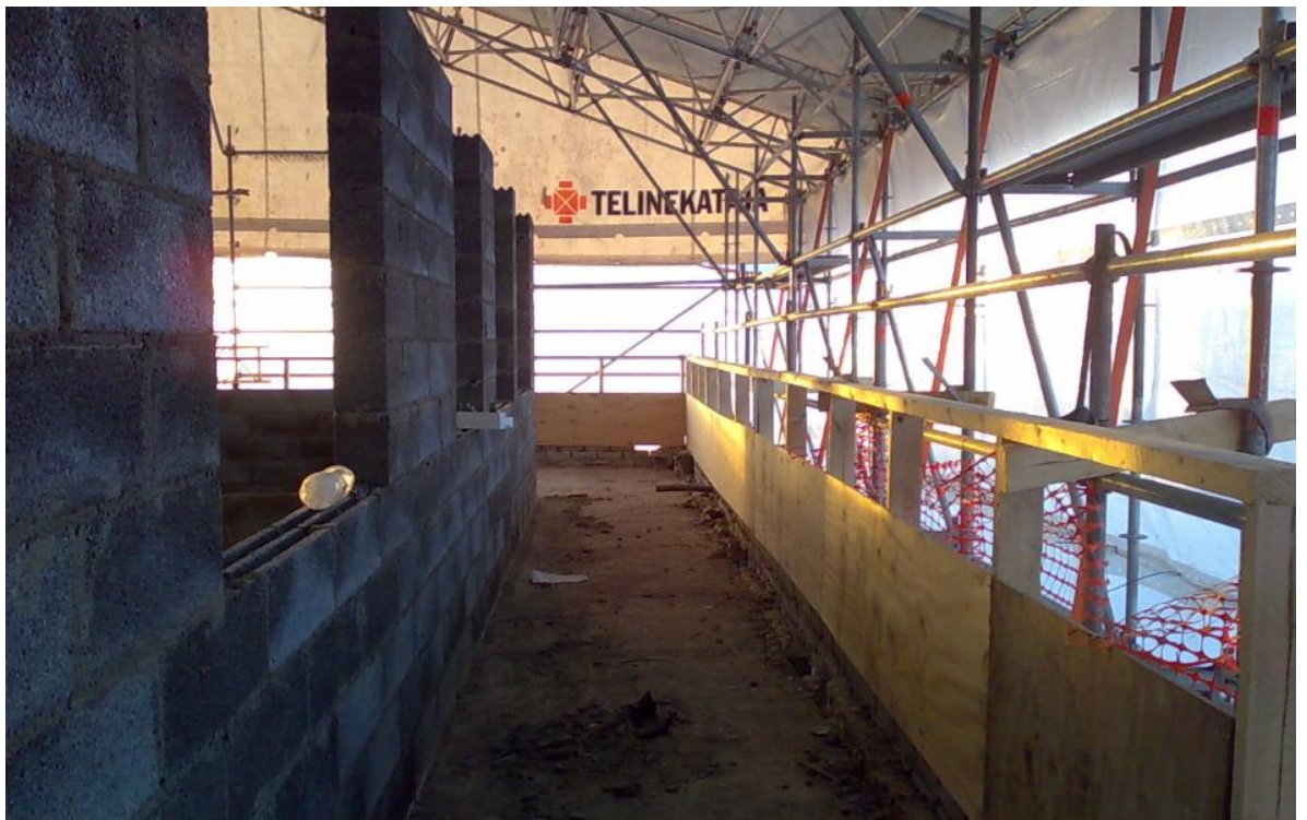
Kuva 20. As Oy Kuopion Kauppakatu 49 ullakkokerros rakenteilla sääsuojan sisällä (Kuva Kimmo Anttonen)
