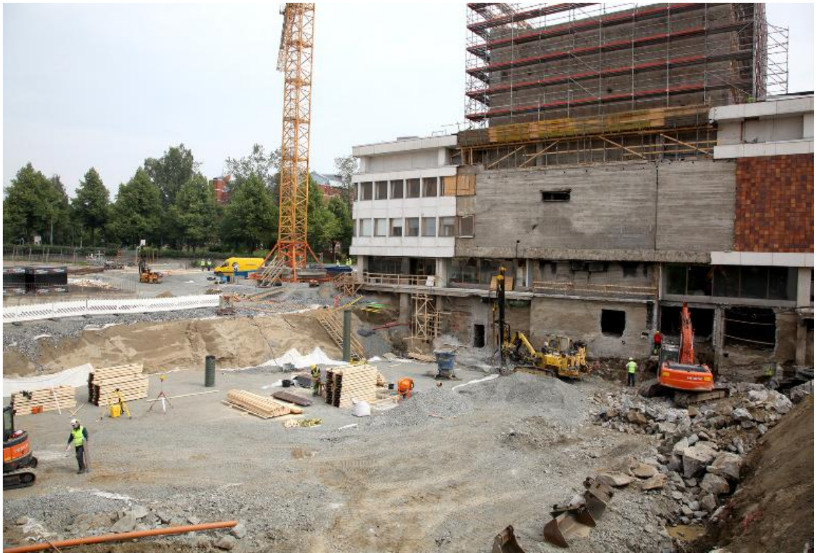
Kuva 18. Kuopion kaupunginteatterin korjaustyö käsittää sekä entisen rakennuksen perusparannusta että laajennusta (Kuva Hanna Tossavainen).
