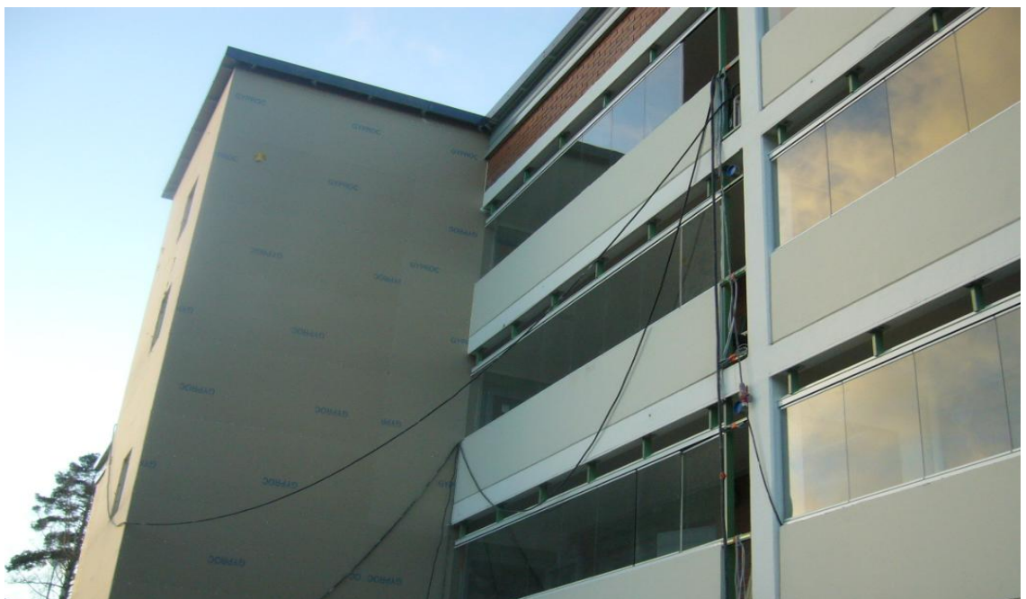
Kuva 21. Katraantie 14 porrashuone rakenteilla (Kuva Kimmo Anttonen).
