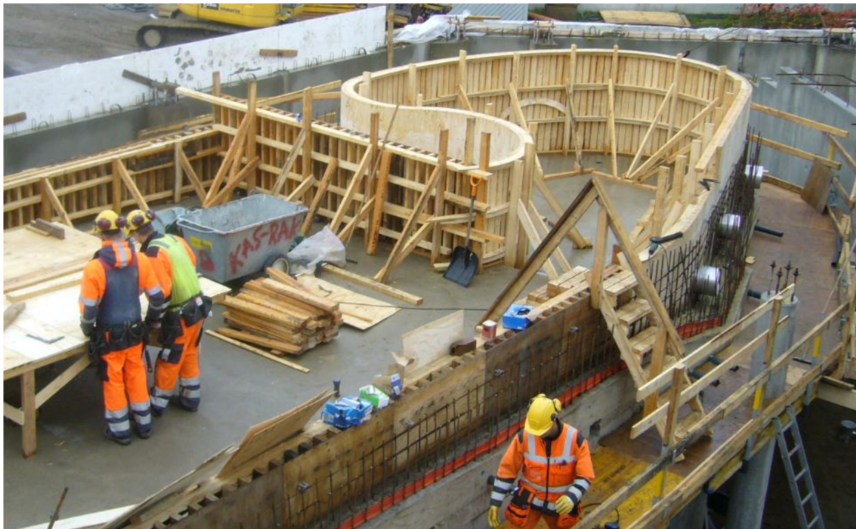
Kuva 16. Tanhuvaaran allasrakenteiden muottityö käynnissä (Kuva Kimmo Anttonen)
