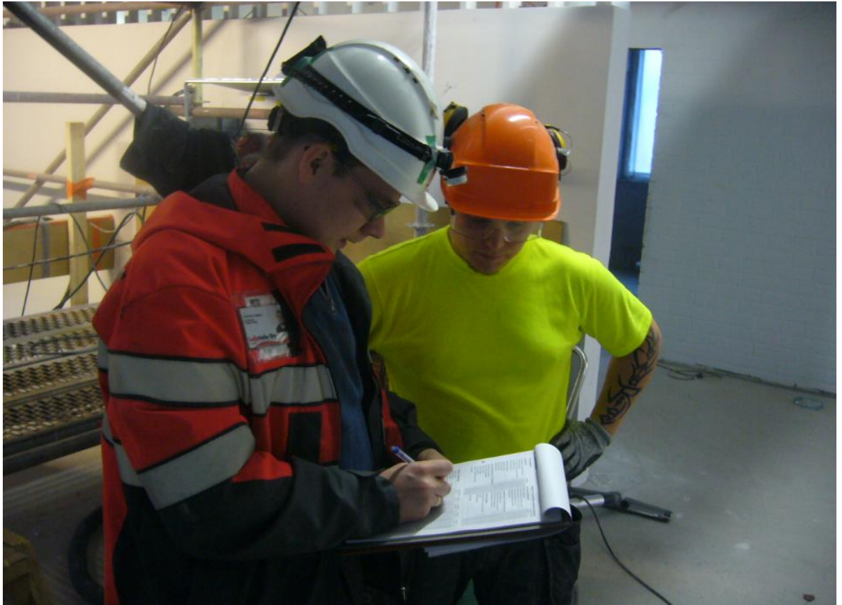
Kuva 19. Työvaiheen kirjallinen laaduntarkastus käynnissä YARAN toimistorakennuksen korjausrakennustyömaalla (Kuva Kimmo Anttonen)
