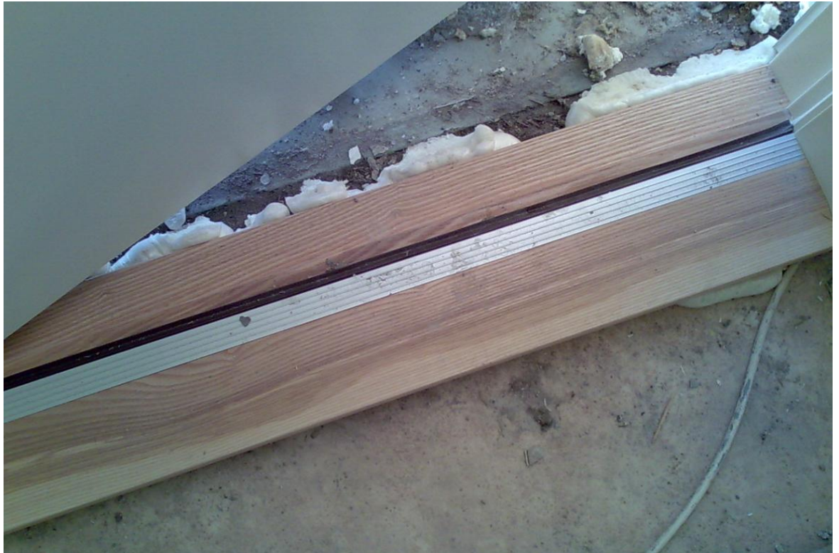
Kuva 26. Kulkuteinä käytettävien parvekkeen ovien kynnyks ja karmit tulisi suojata huolellisesti esim. kynnyksellä (Kuva Kimmo Anttonen).
