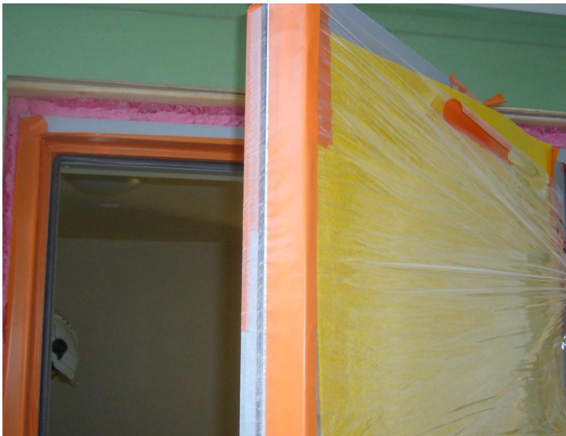
Kuva 27. Esimerkillisesti toteutettu ulko-oven työaikainen suojaus Kumonin työmaalta (Kuva Kimmo Anttonen).
