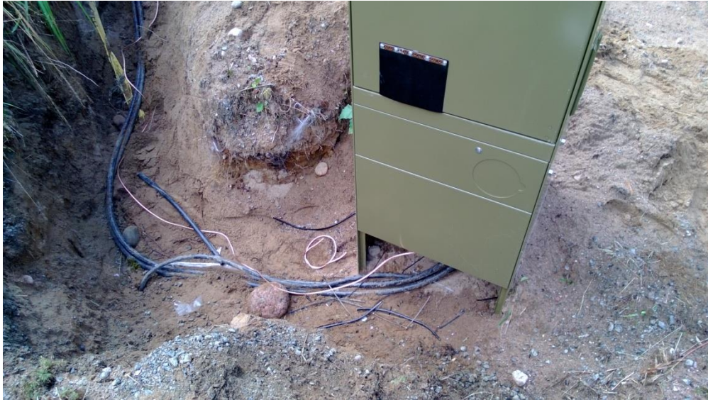
KUVA 5. Maahan asennettuja kaapeleita
