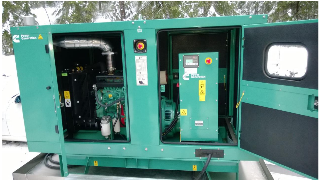
KUVA 1. Cummins-dieselgeneraattori
