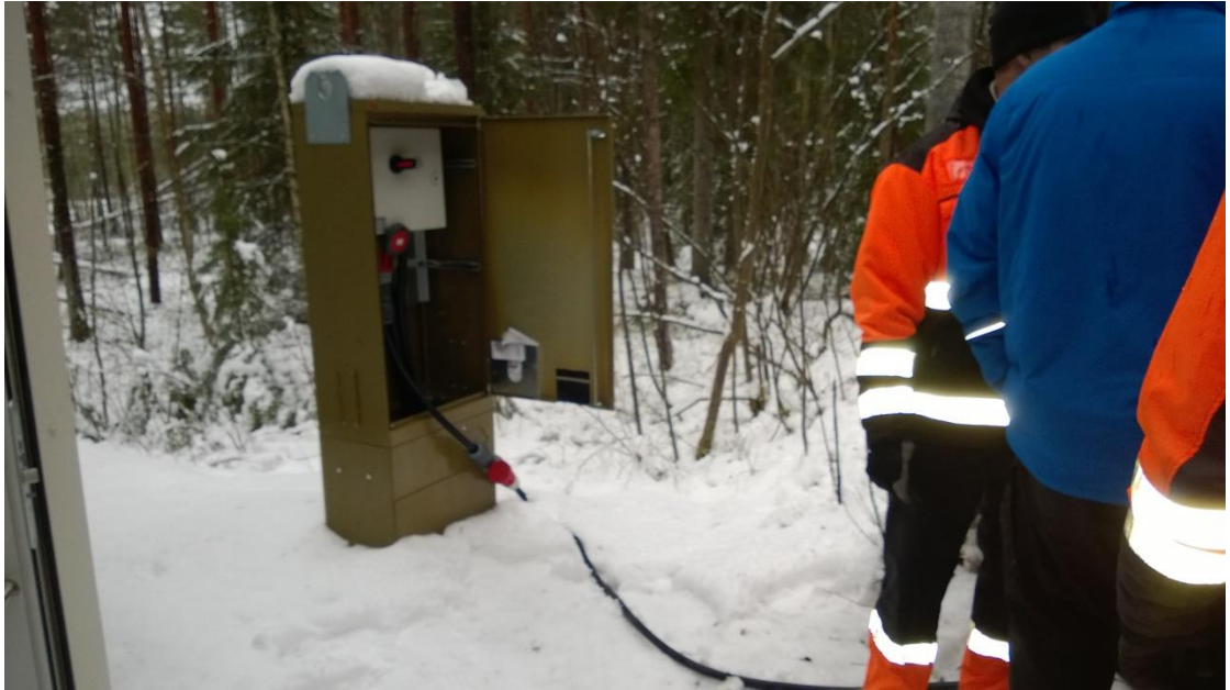
KUVA 3. Varavoimakeskus käytössä
