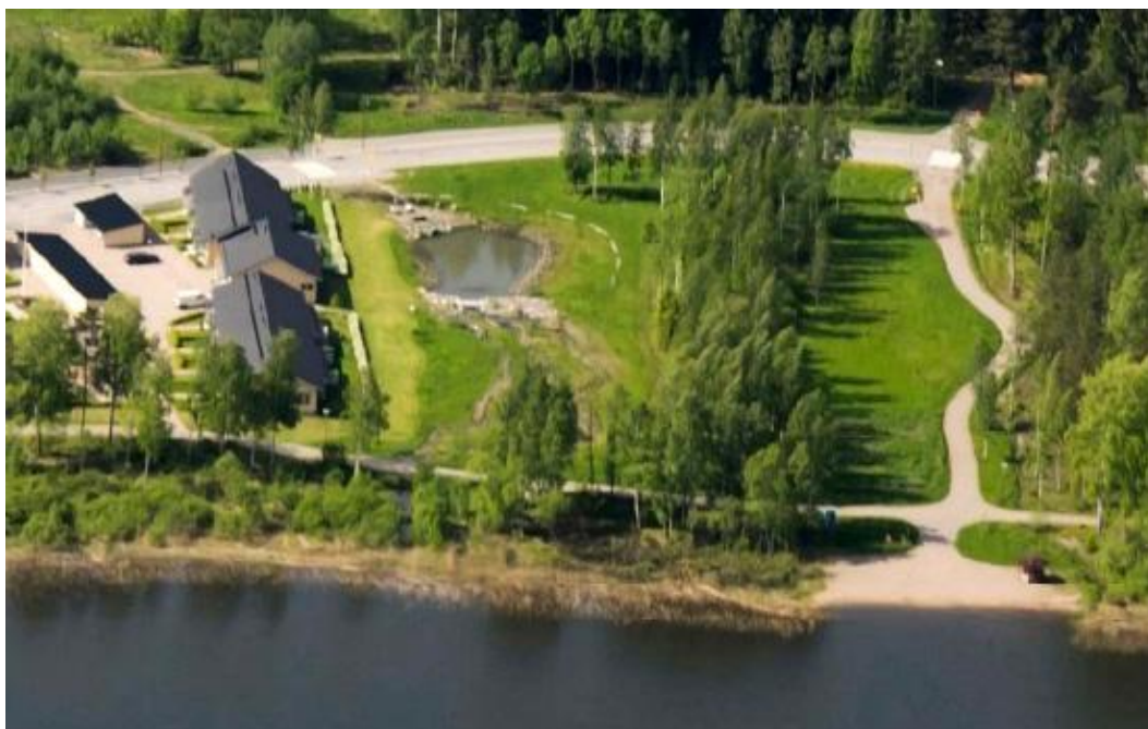
KUVA 8. Rantakylän hulevesiallas ilmakuvassa (Lahden kaupunki 2013b)
