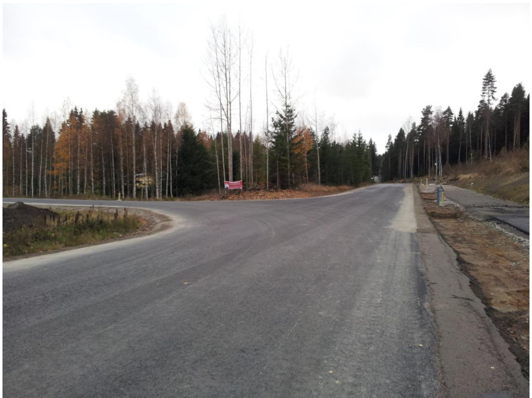
KUVA 17. Kytölän uuden asuntoalueen katuyhteyden tuore asfalttipinta
