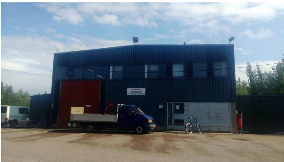
Kuva 4. Oheisessa kuvassa korjaamorakennuksen sisäänkäynti.
