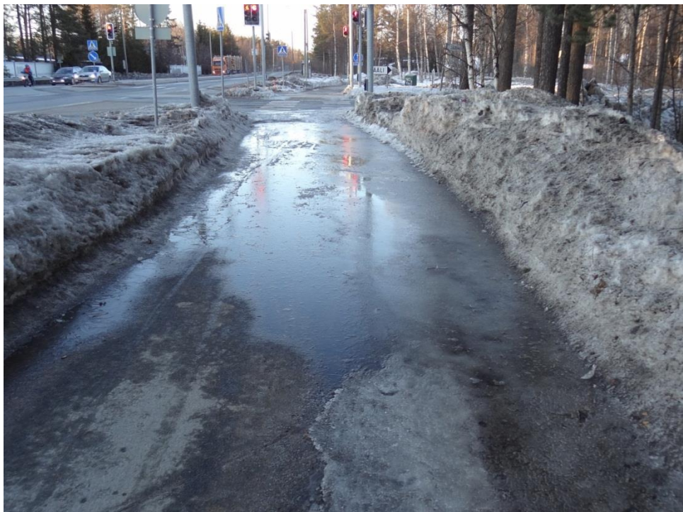
Kuva 27. Seisova sulamisvesi kevyen liikenteen väylällä aiheuttaa ongelmia. Kiiminginsuunnan reitti.
