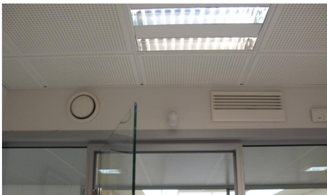
Kuva 28. Lasiseinärakenteen yläpuolinen otsarakenne LVI-läpivienteineen.
